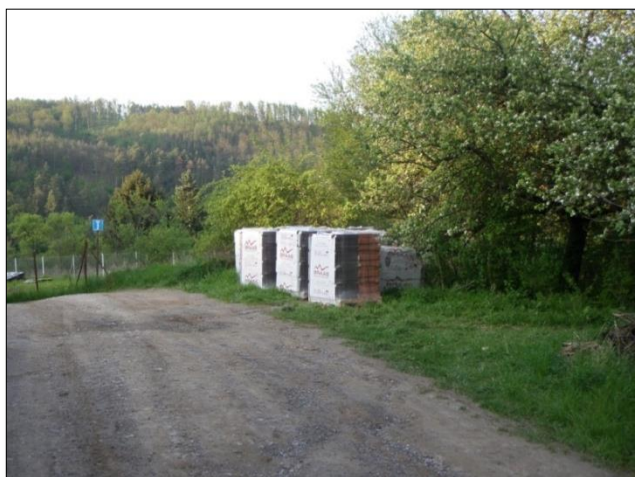
Obr. 31: Neoprávněný zábor půdy stavebním materiálem (zdroj: vlastní foto)
