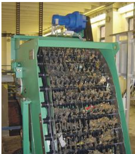
Obr. 3: Strojně stírané hrubé česle ( http://www.fontanar.cz/mechanicke-predcistení.php , 2017)
