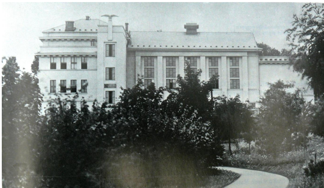
28. Červený Kostelec, sokolovna, 1932, František Holý. Foto: Ludvík Mühlstein, Jiří Šolc, Červený Kostelec , Červený Kostelec 1988, s. 31.
