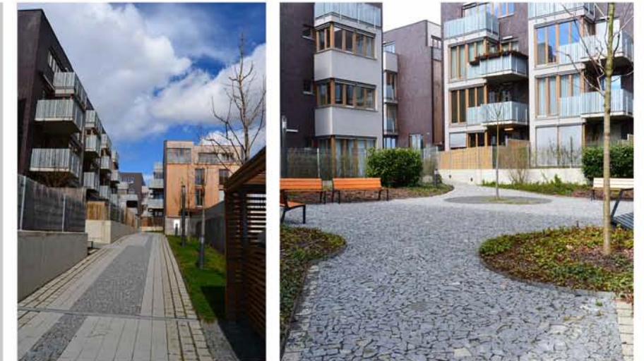
Obr. 26: Veřejně přístupná centrální část (Autor, 2015)
