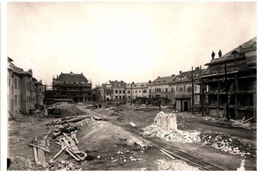
▲ Obr. 51: První fáze výstavby z roku 1921
