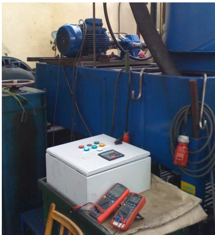
Obr. 42 Uspořádání pracoviště (rozvodná krabice)
