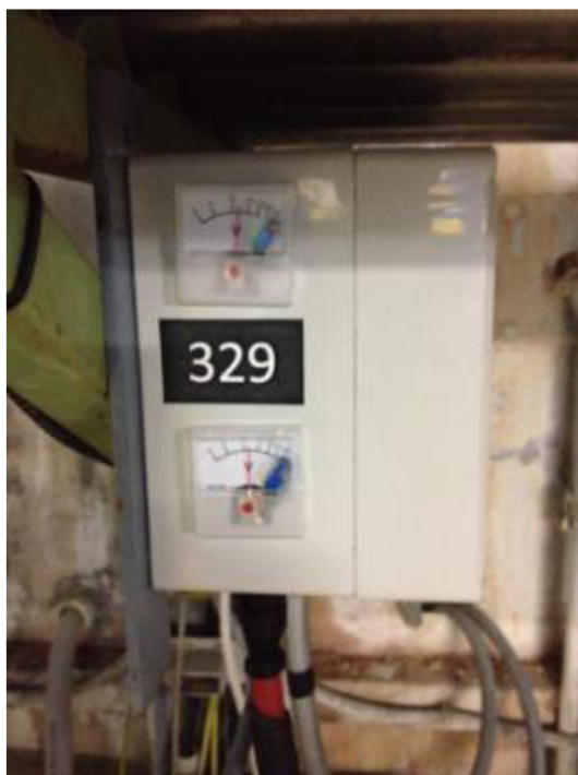
Obr. 37 Boční ukazatele úrovně signálu s vestavěným trimrem
