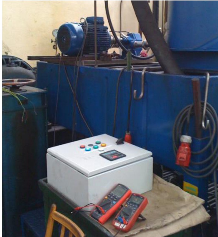
Obr. 42 Uspořádání pracoviště (rozvodná krabice)
