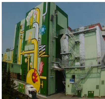
Obr. č. 15 Energoblok K7 (PT 2010)
