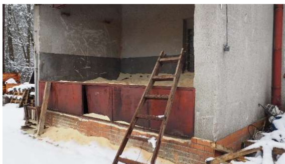
Obr. 32 Skladování pilin pro vytápění
