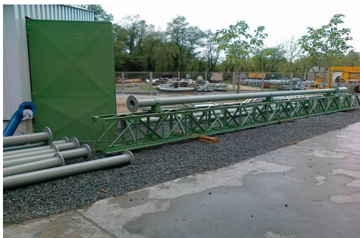
Obr. 3.2 Hotový příhradový most před montáží
