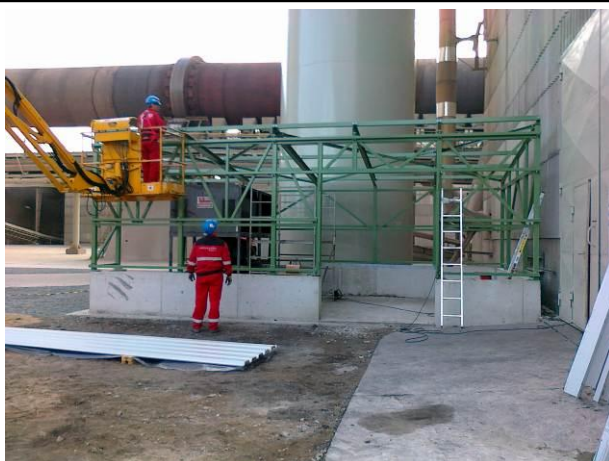
Obr. 2.5 Montáž konstrukce kompresorovny
