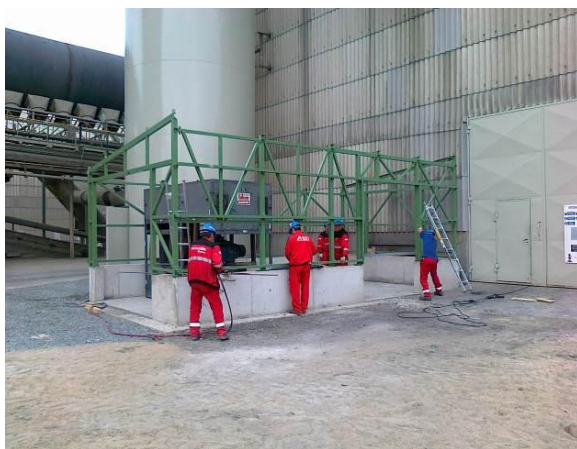
Obr. 6.4 Montáž konstrukce kompresorovny
