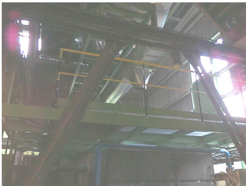
Obr. 7.1. Montáž nosníku do OK
