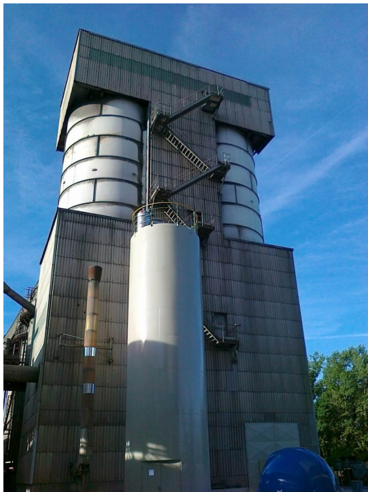
Obr. 1 Stav mlýnice před rekonstrukcí
