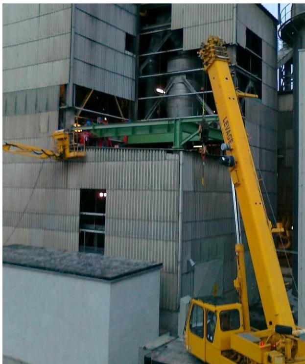
Obr. 7.3. Montáž nosníku do OK
