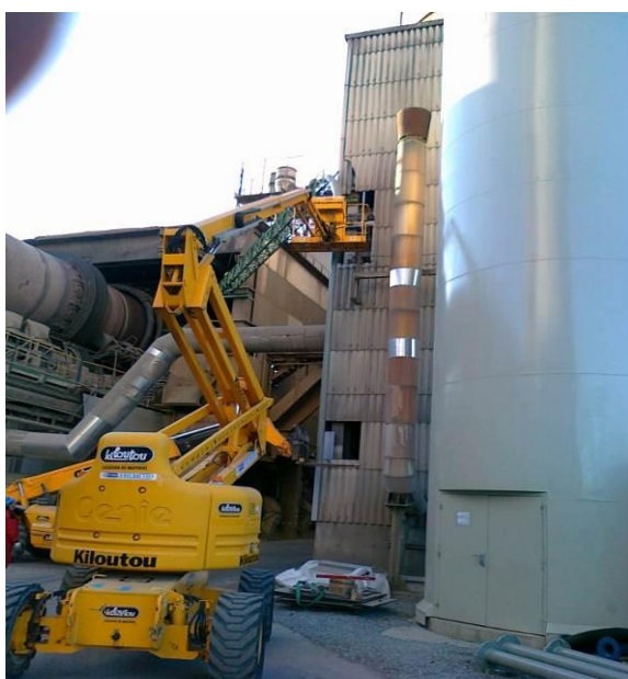
Obr. 3.3 Montáž konzol mostu
