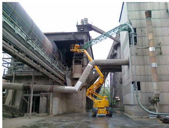
Obr. 6.7 Most s namontovaným potrubím
