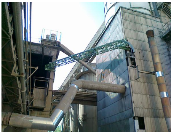
Obr. 6.6 Montáž příhradového mostu
