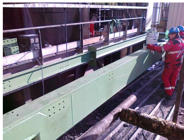
Obr. 3.7 Natírání otvorů
