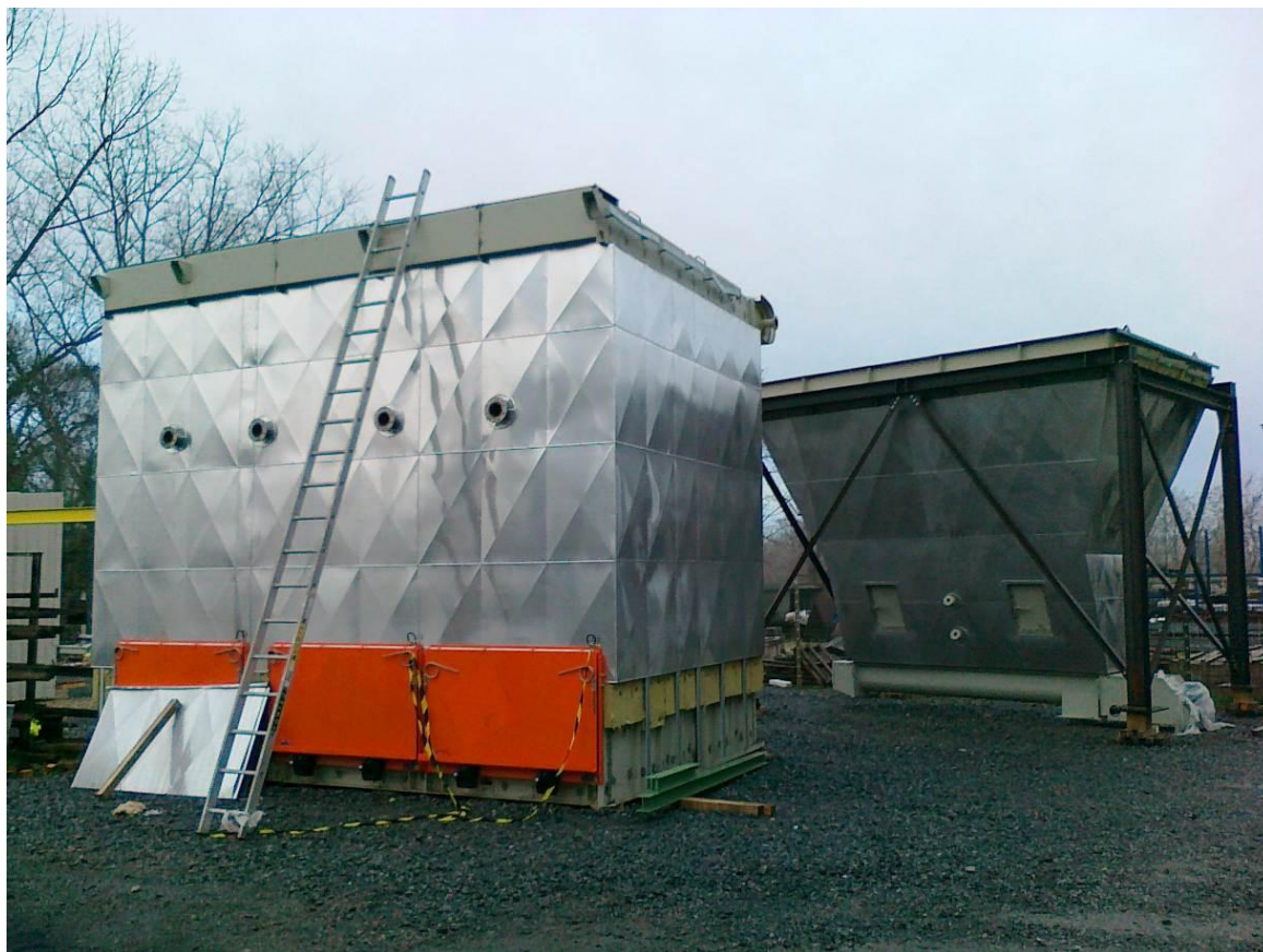
Obr. 2.7 Filtr INTENSIV v předmontážním stavu. Vlevo: tělo filtru s klapkami, vpravo: výsypka
