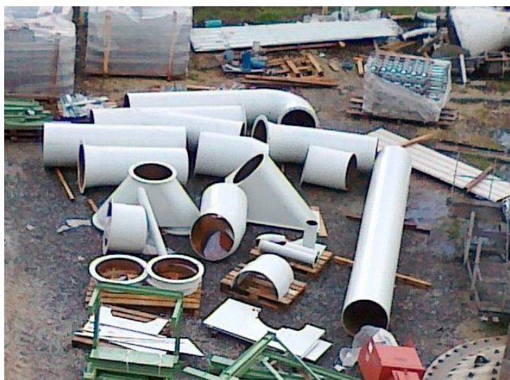
Obr. 7.4. Potrubí DN 700 / DN 800 připravené k montáži
