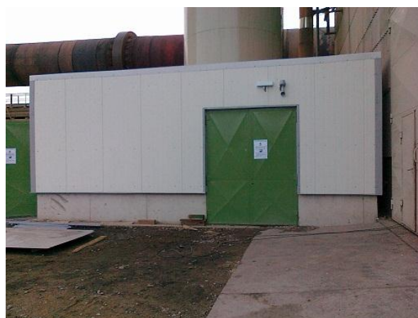
Obr. 6.5 Kompresorovna s opláštěním
