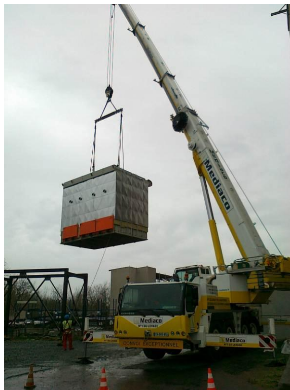
Obr. 3.7 Usazování těla filtru
