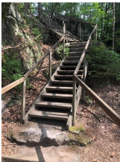
Obr. 65 Část schodiště tvořená schody z CB a konstrukcí z fošen.
