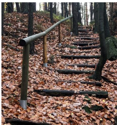
Obr. 81 Jeden z objektů schodů MOS32
