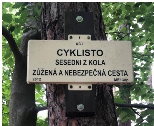
Obr. 107 Typ 4 osazení turistické tabulky na dřevěnou lištu odpovídající metodice umístění na stromy dle ČSN 01 8025
