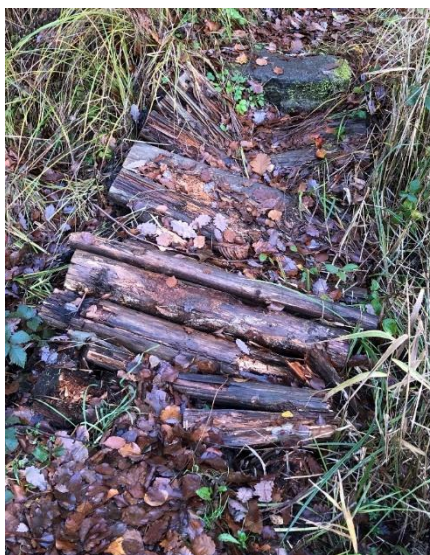
Obr. 85 Konstrukce lávky MOS36
