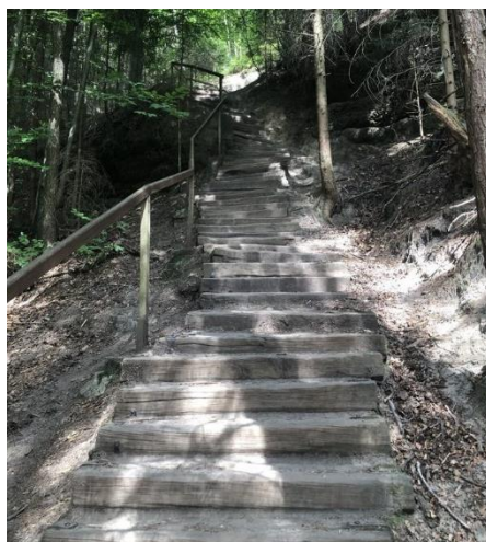
Obr. 66 Spodní část schodiště tvořená ukotvenými prahy
