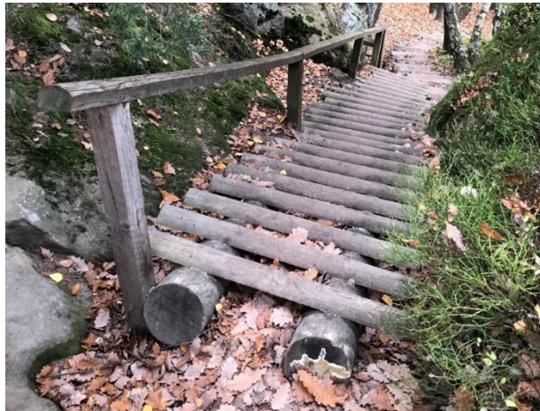
Obr. 73 Schodiště a schody MOS23
