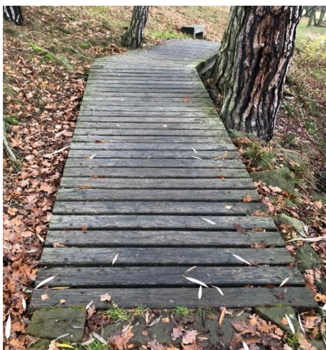
Obr. 91 Chodník MOS 44 umístěný na hrázi Máchova jezera
