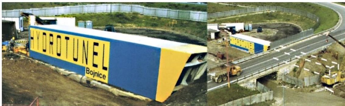
Obr. 20 Podchod pre chodcov a cyklistov, Bratislava – pretláčanie pravouhlého železobetónového monobloku tunelovej rúry z úrovne terénu bez pracovnej šachty [24]
