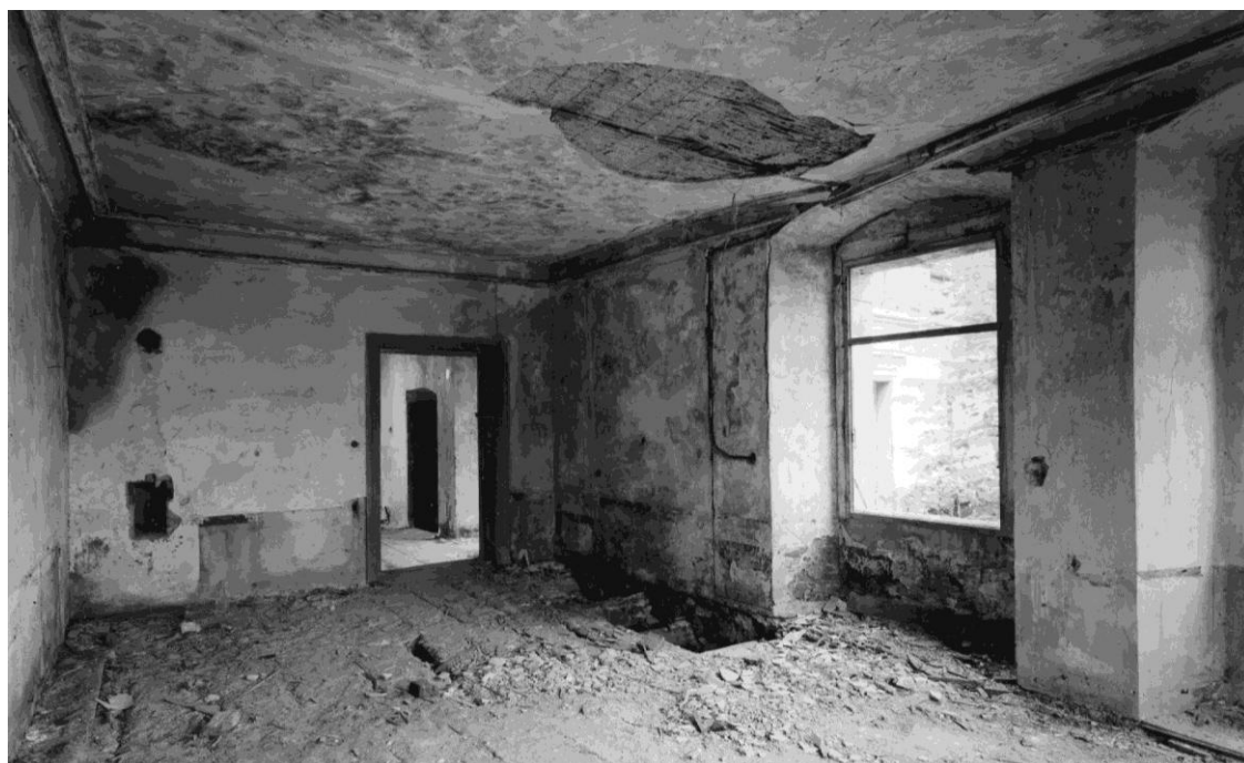
Obr. 32: Místnost s vchodem na terasu nad Rytířským sálem, viz stopa po táflování do výše okenních parapetů
