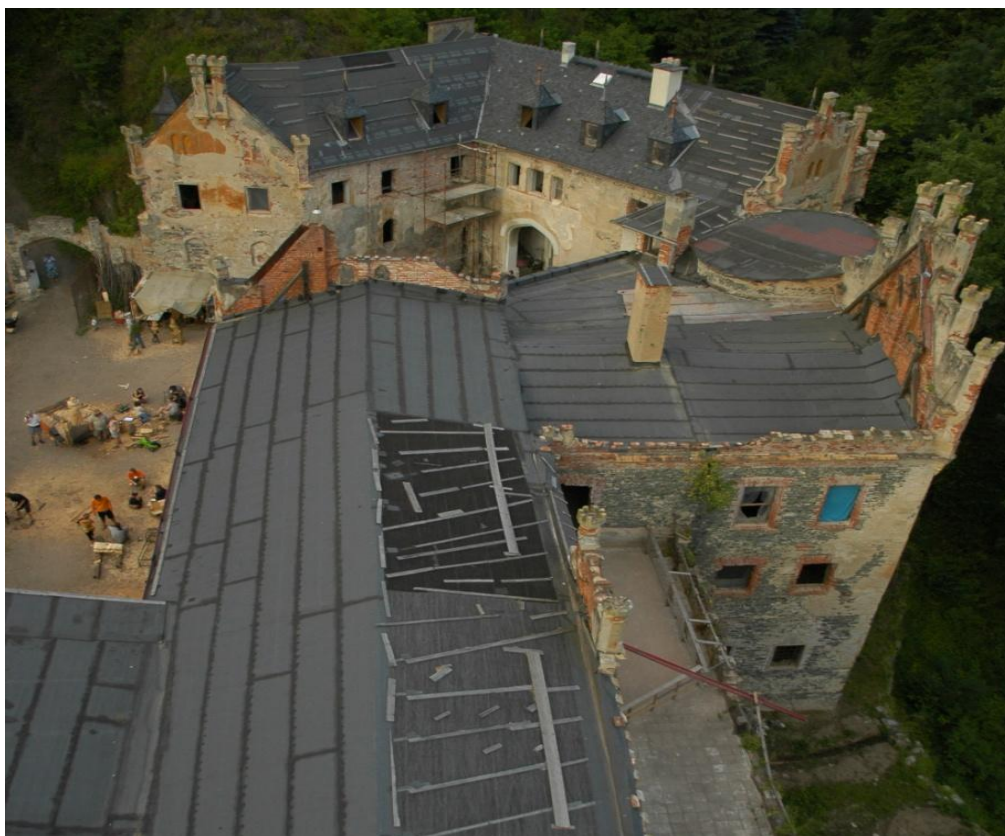
Obr 25: Průběh rekonstrukcí Hauenštejna, 2005
