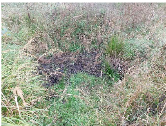
Obr. 38 – Zazemňování tůň T05 v DB v důsledku sesuvu břehů. Foto: Iva Princová
