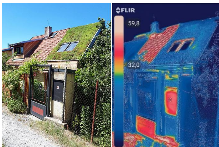
Obr. 21 - Termosnímek rodinného domu s aplikovanou zelenou střechou [48]
