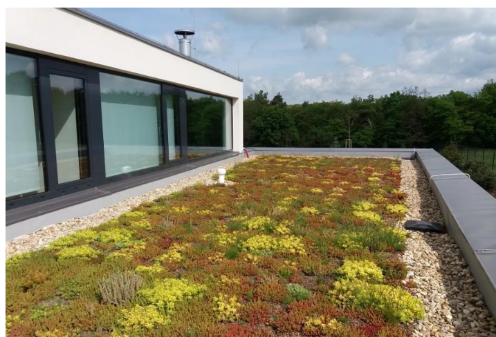
Obr. 22 - Extenzivní zelená střecha [49]
