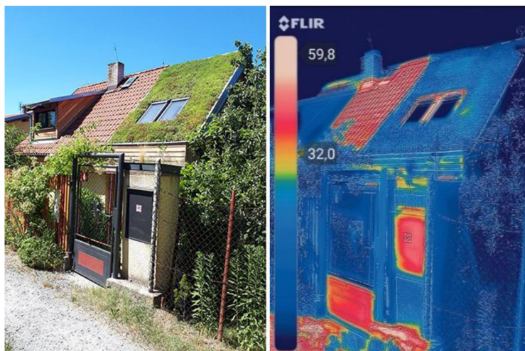
Obr. 21 - Termosnímek rodinného domu s aplikovanou zelenou střechou [48]
