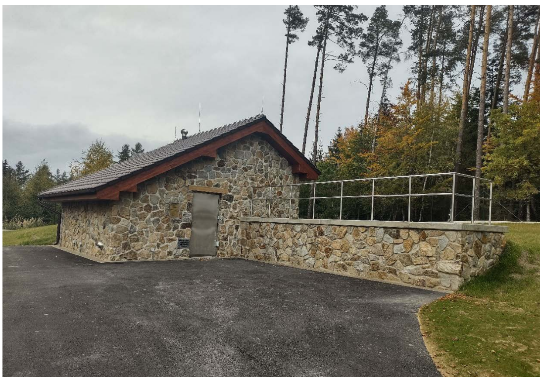
Příloha 5: Hlavní vodojem skupinového vodovodu v Zálesí
