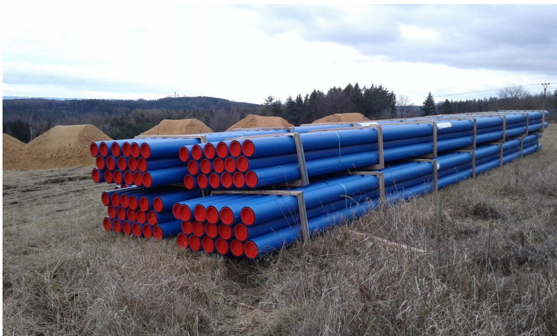
Příloha 6: Připravené potrubí Gerodur před pokládkou
