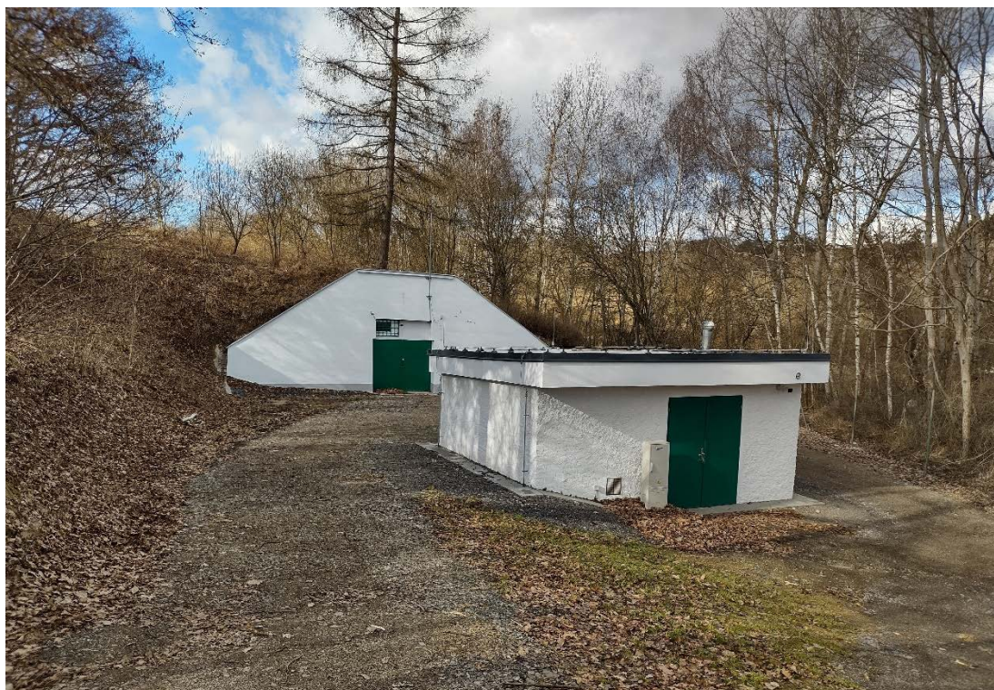
Příloha 3: Vstup do úpadnice přivaděče ze Želivky v Křešicích
