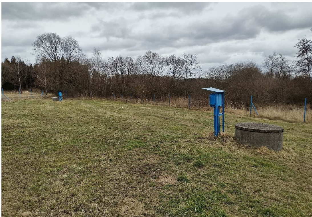
Příloha 2: Část ze soustavy studní, odkud byla jímána voda pro osadu Struhařov
