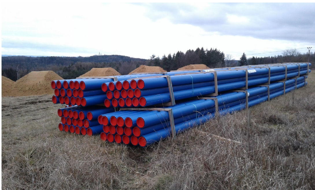
Příloha 6: Připravené potrubí Gerodur před pokládkou
