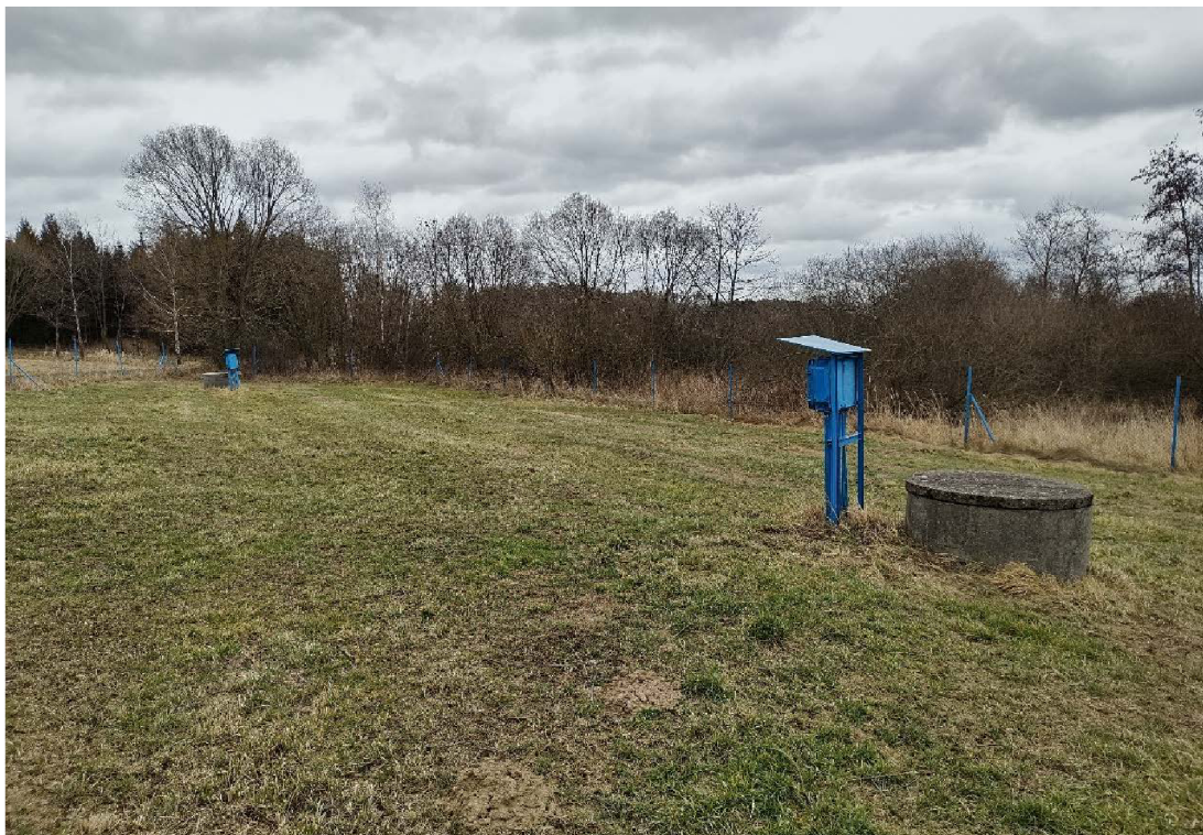
Příloha 2: Část ze soustavy studní, odkud byla jímána voda pro osadu Struhařov
