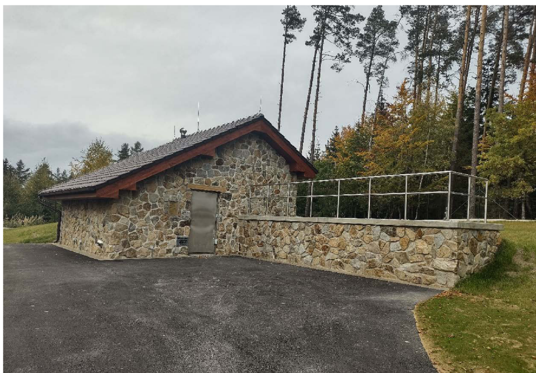
Příloha 5: Hlavní vodojem skupinového vodovodu v Zálesí
