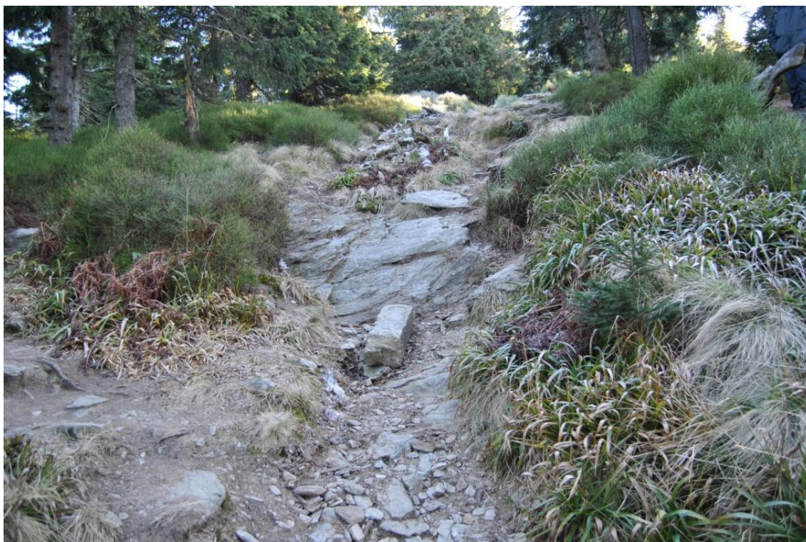
Obr. 19 Stezka způsobující výraznou vodní erozi v době dešťů v oblasti Malého Dědu v roce 2018 (foto: vlastní)
