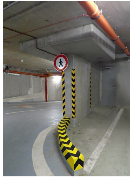
Obr. 14 Celkový pohled na dokončenou konstrukci
