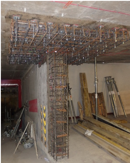
Obr. 13 Pohled na armokoš hlavice a prodloužení stěny
