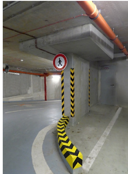
Obr. 14 Celkový pohled na dokončenou konstrukci
