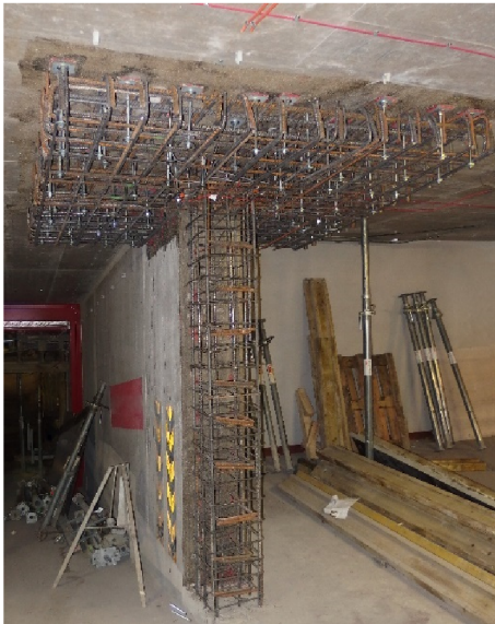
Obr. 13 Pohled na armokoš hlavice a prodloužení stěny
