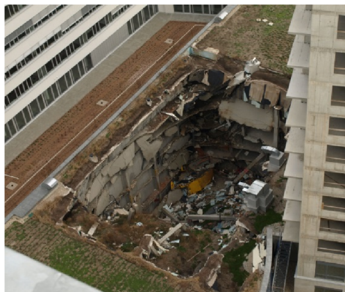
Obr. 4 Havárie polyfunkčního komplexu Trinity, Bratislava, 2012 [3]
