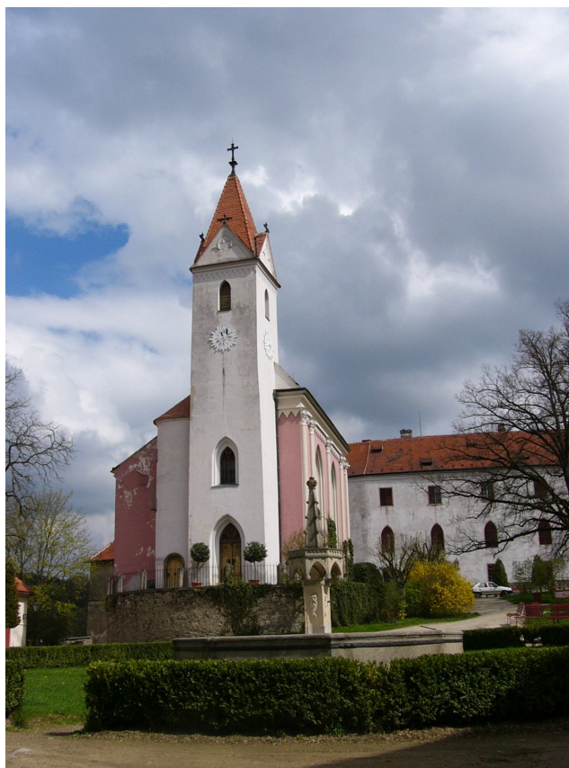
Obr. 3 Kaple Nanebevzetí Pany Marie, pohled od západu, foto Jan Binder
