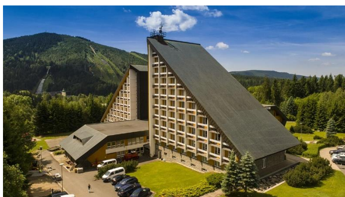
Obrázek 7 - Budova OREA hotelu Sklář Zdroj: OREA Resort Sklář Harrachov, 2016
