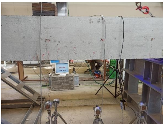
obr. 7.8: vznik a rozvoj trhlin – vzorek A [ 19 ]
