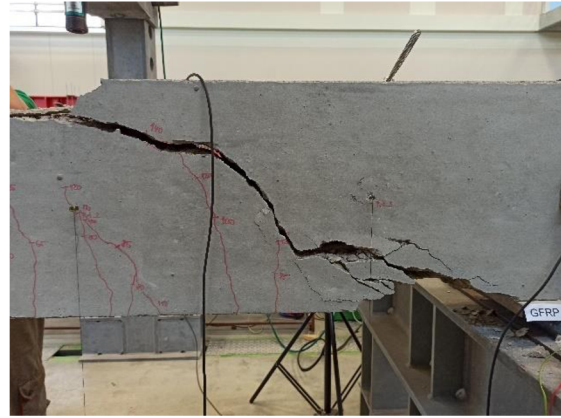
obr. 7.15: detail porušení nosníku – vzorek B [ 19 ]
