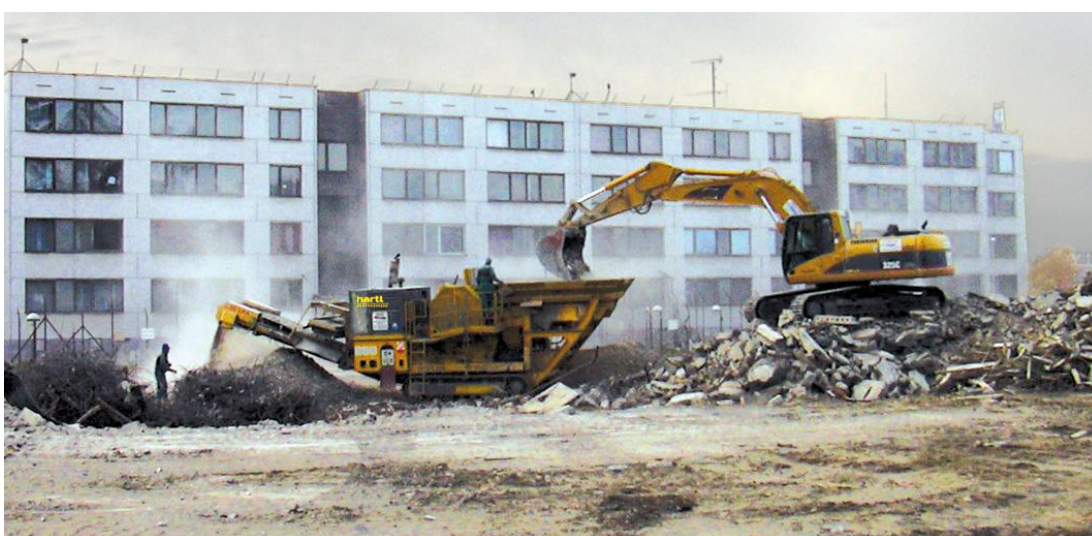
Příloha č. 7 Mobilní pásový čelistový drtič při recyklaci stavebních odpadů
