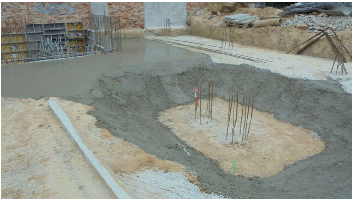
Obr. 9.1 Podkladní betony [vlastní tvorba autora]
