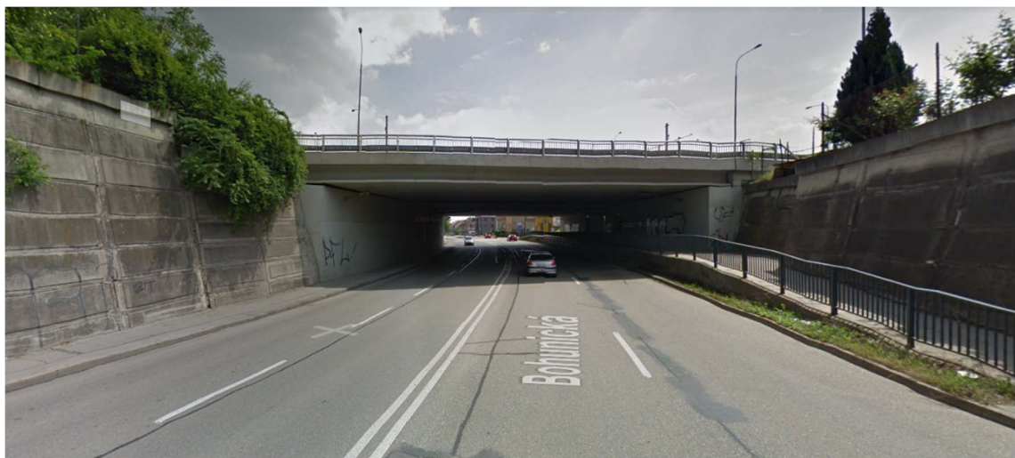
Obr. 2.9 Podjezd na ulici Bohunická – pohled z ulice [2]
