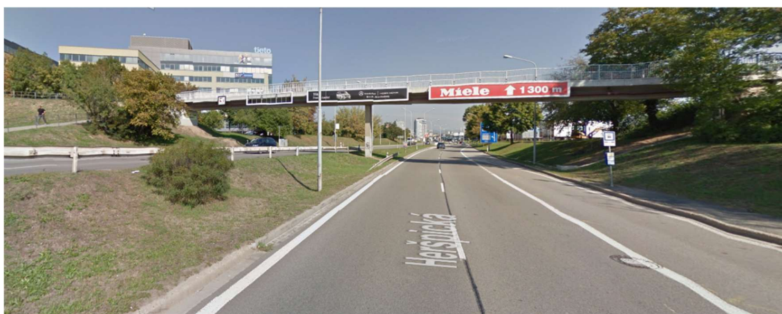
Obr. 2.11 Podjezd na ulici Heršpická – pohled z ulice [2]
