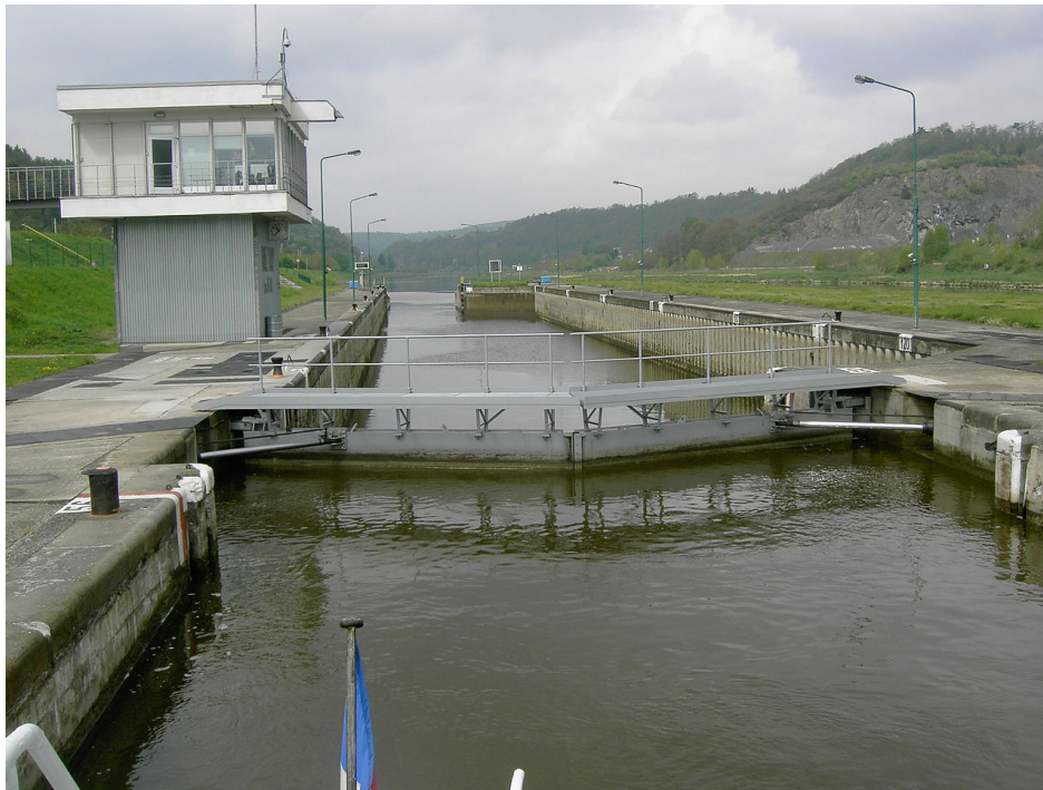
Obrázek 9 - Poproudňní pohled na velín a uzavřená střední vrata mezi plavebními komorami [D3]
