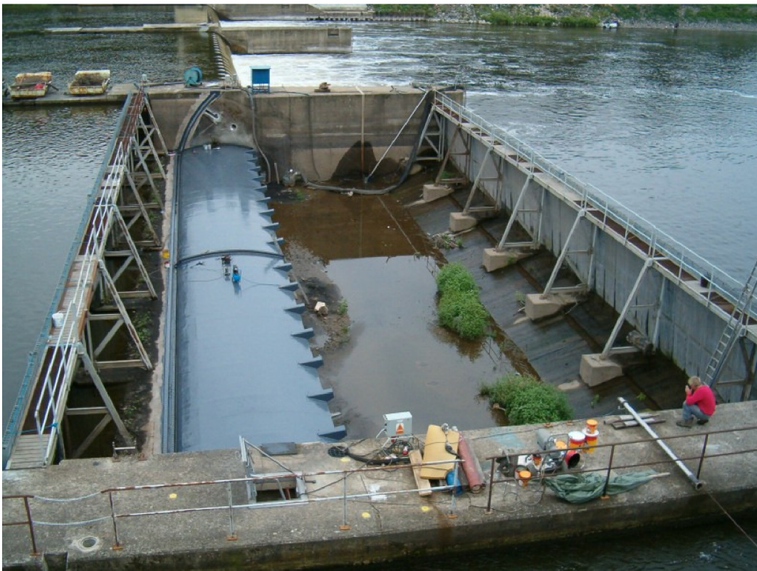
Obrázek 7 - Instalace ocelového hradlového provizorního hrazení v pravém poli [D2]
