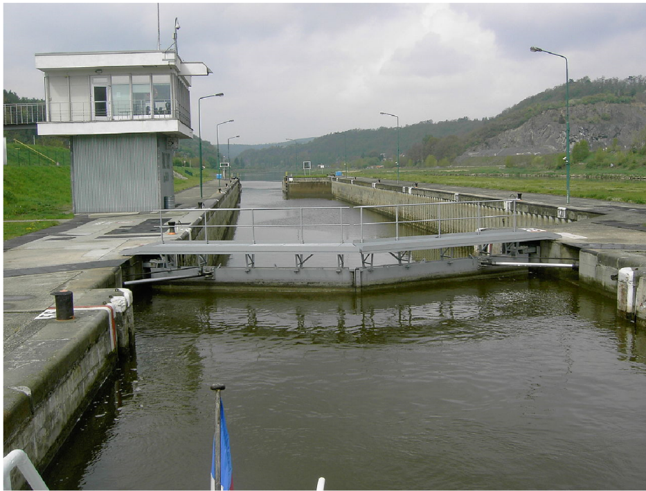
Obrázek 9 - Popravní pohled na velín a uzavřená střední vrata mezi plavebními komorami [D3]
