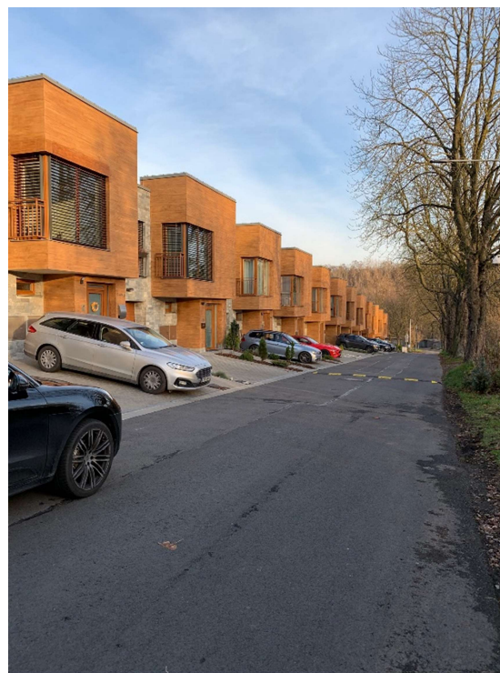
Obr. 18 Zástavba na ulici Na Šestém
