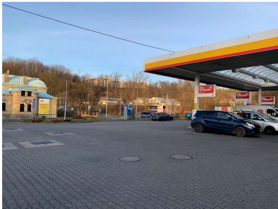
Obr. 19 Benzinová stanice na ulici Těšínská
