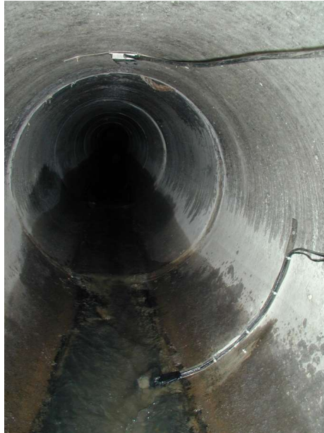
Obr. 43 Ukázka instalace průtokoměru ADS 3600 [17]
