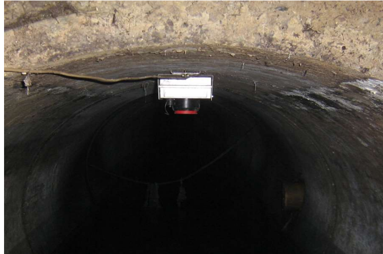
Obr. 42 Ukázka instalace hladinoměru [17]
