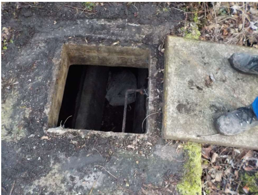
Obr. 3 Vstup do OK Na Baranovci [OVAK a.s.]
