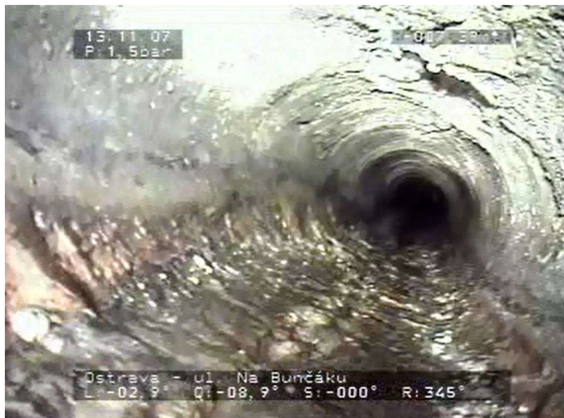
Obr. 27 Zborcení na úseku u01 [OVAK a.s.]
