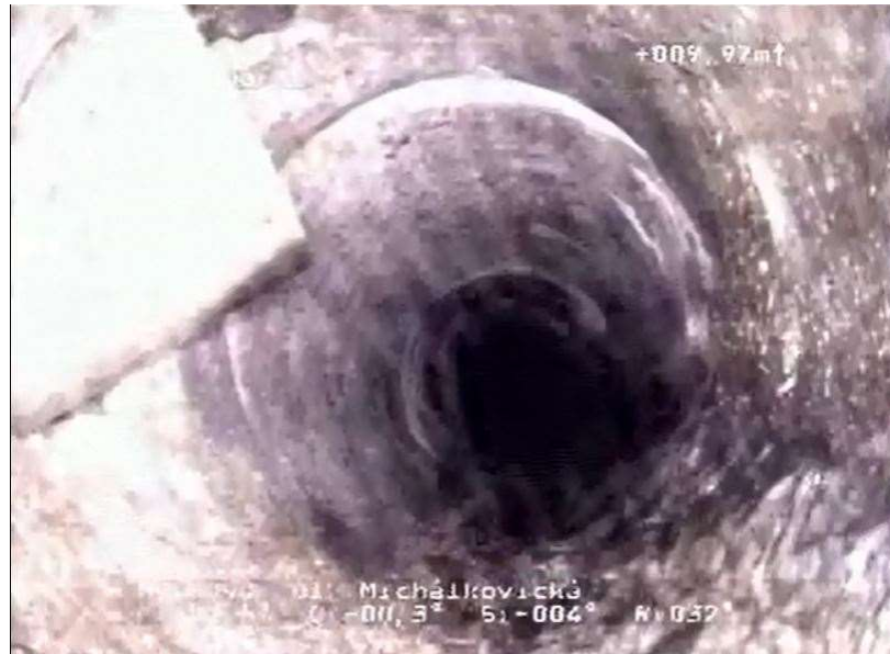
Obr. 38 Přesazená přípojka na úseku U15 [OVAK a.s.]
