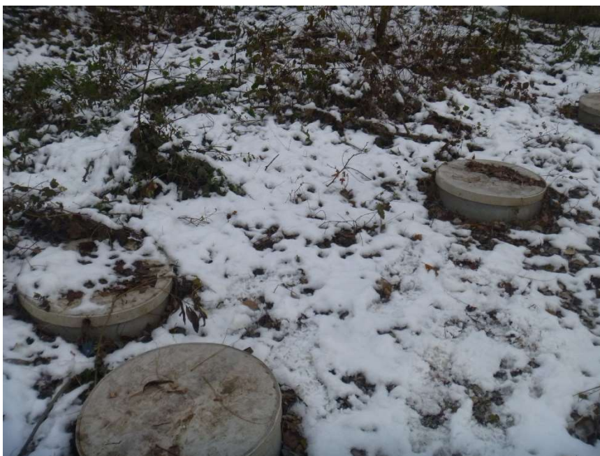
Obr. 5 Pohled na vstup do septiku Na Baranovci [OVAK a.s.]
