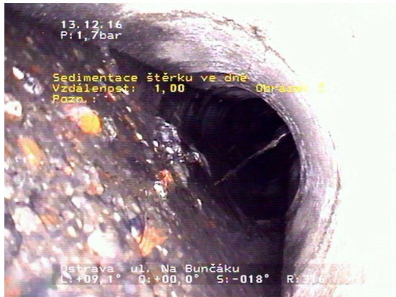
Obr. 35 Štěrkový sediment na úseku u18 [OVAK a.s.]
