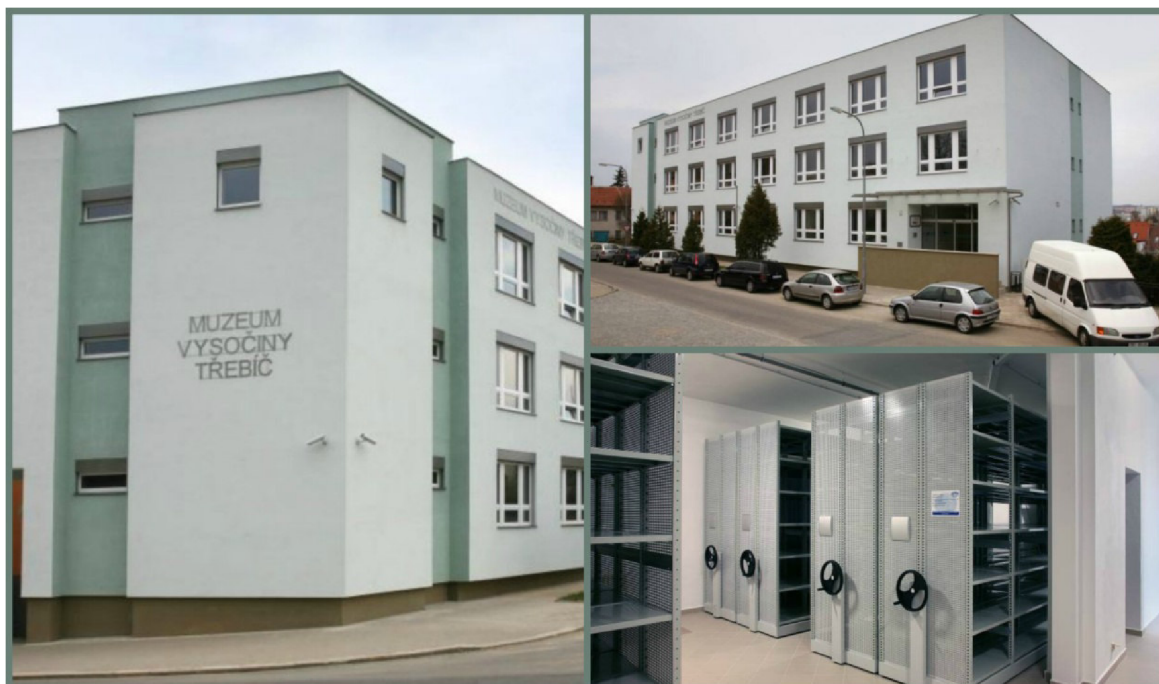
7.2 Depozitáře Muzea Vysočiny fotodokumentace [Zdroj: www.stavbavysociny.cz]
