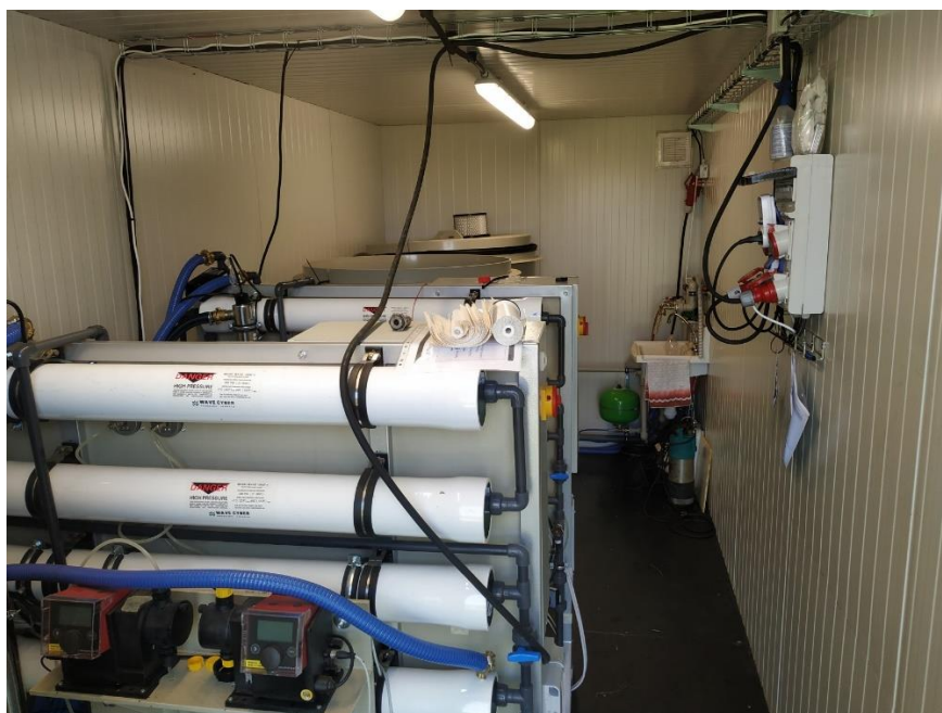
Obrázek 29: Fotodokumentace z lokace ČOV – membrány
