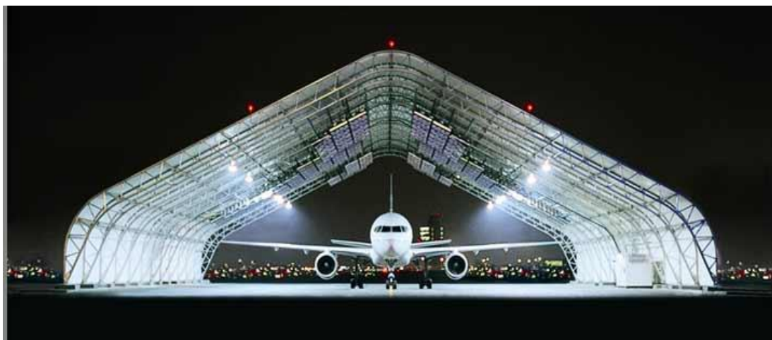
Obrázek 2: Proces odmrazování letadla Systém InfraTek™
