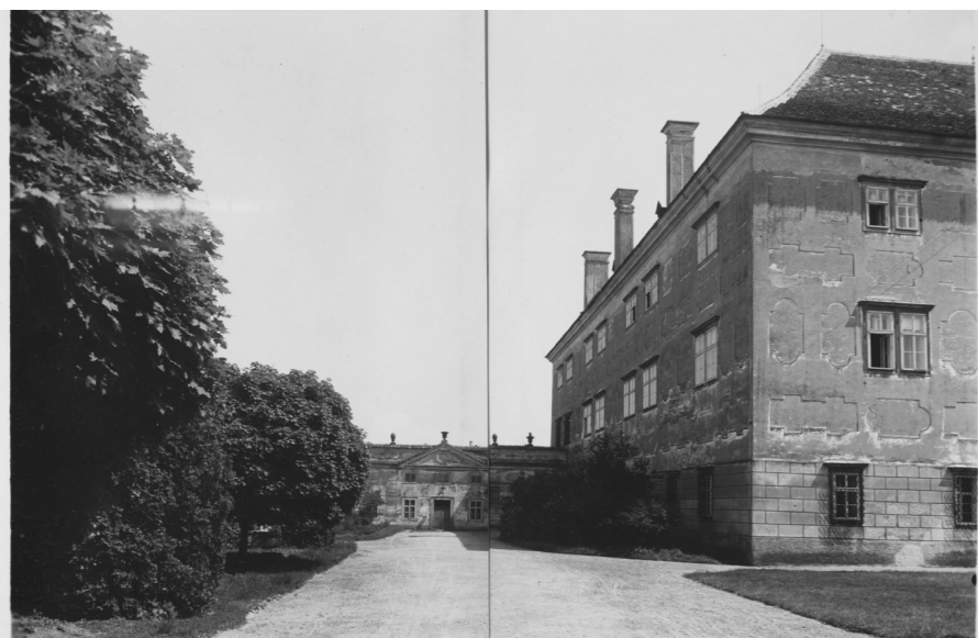
Obr.54: Východní zákoutí nádvoří, 1948
