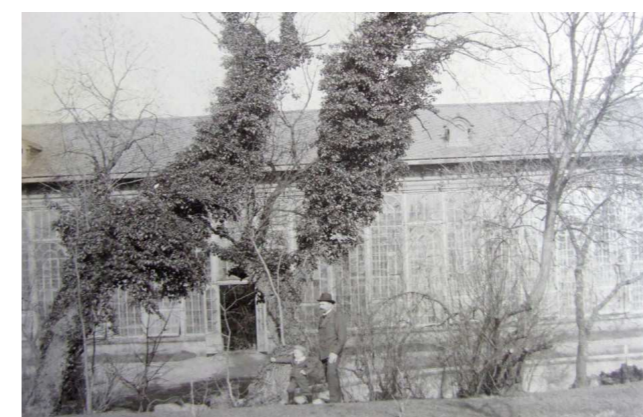
Obr.23: JV průčelí oranžerie, přelom 19. a 20. století
