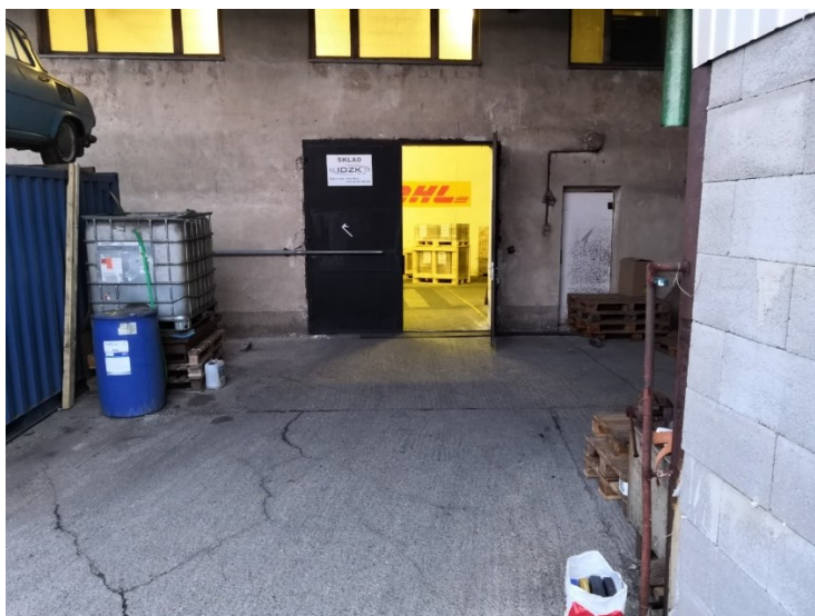
Obr. 2.4 Nakladacia rampa – súčasný stav
