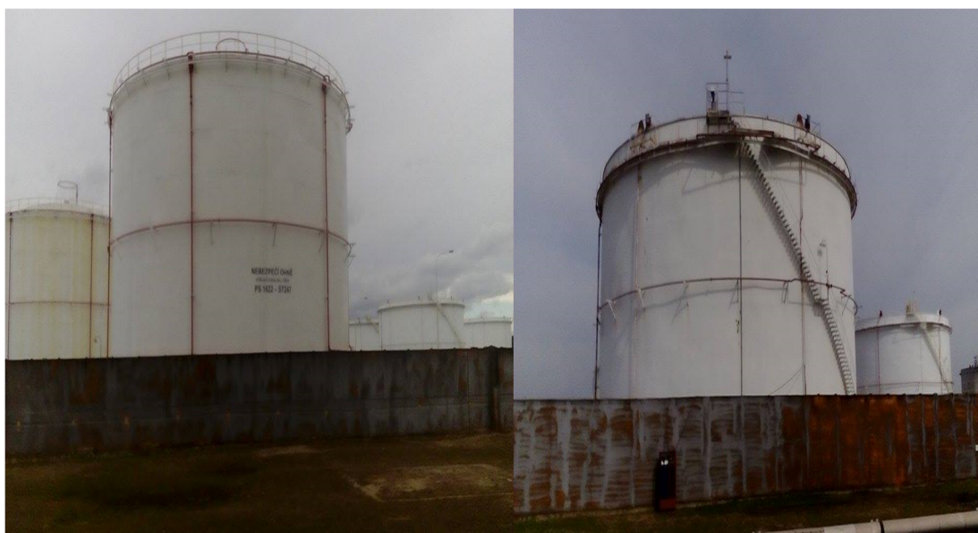
Obrázek 12: Ocelové nádrže v areálu Synthos Kralupy a.s., zdroj: (vlastní fotodokumentace)
