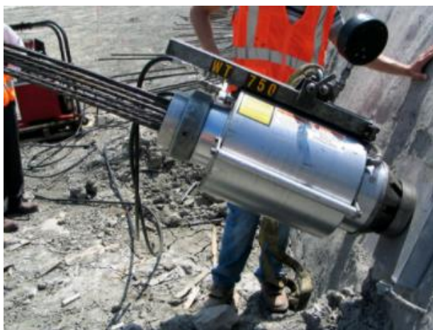
Obrázok 93 - Ilustračný obrázok - Predpínacie zariadenie [22]
