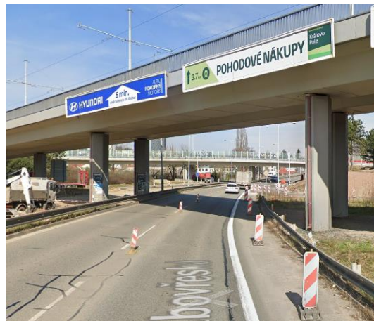
Obrázok 20 - Prejazd pod železničný most 2 [3]
