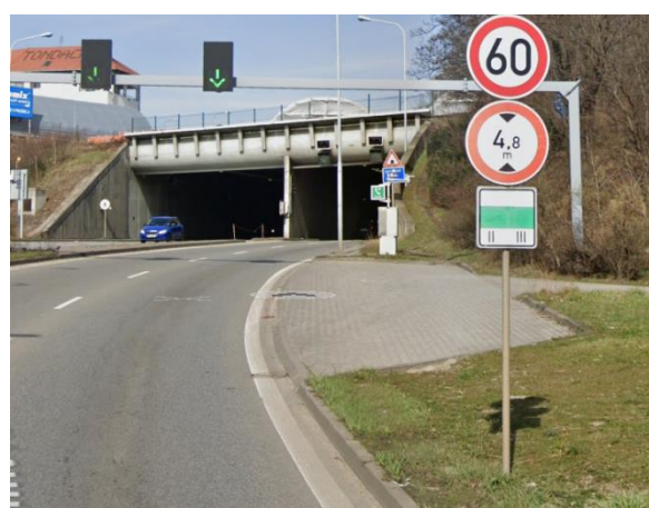
Obrázok 57 - Vjazd do tunela - pohľad [3]
