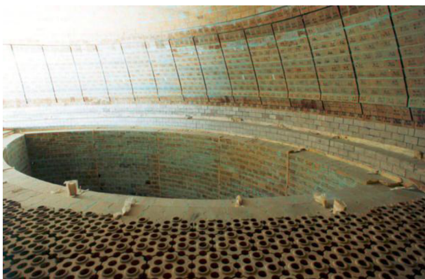
Obrázek 8: Vnitřní vyzdívka ohřivače větru [5]
