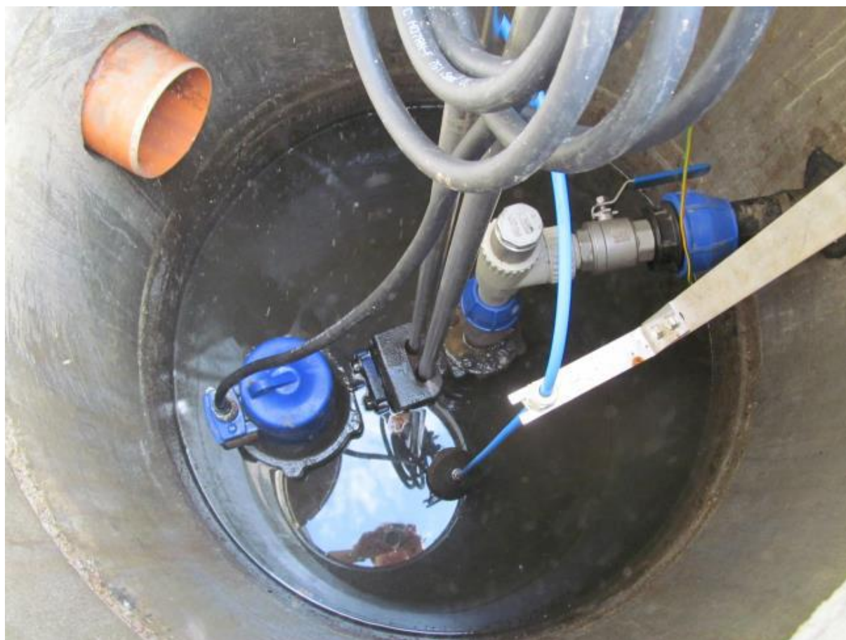
Obr. 3.10 - Domovní čerpací jímka s odstředivým ponorným čerpadlem [6]
