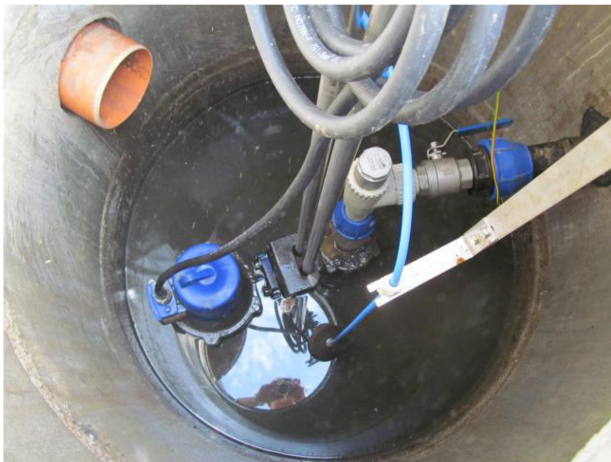
Obr. 3.10 - Domovní čerpací jímka s odstředivým ponorným čerpadlem [6]
