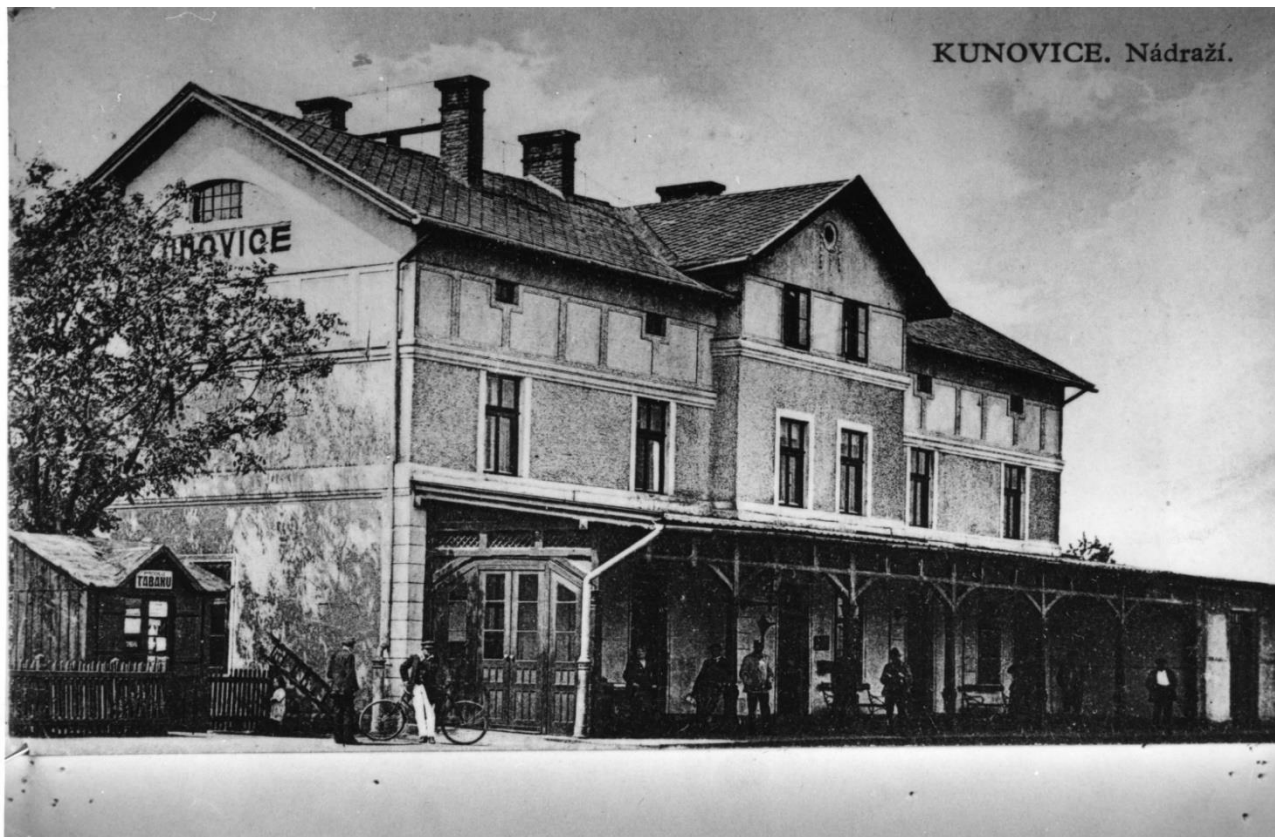
30/ Kunovice, výpravní budova, kol. 1898-1900.
