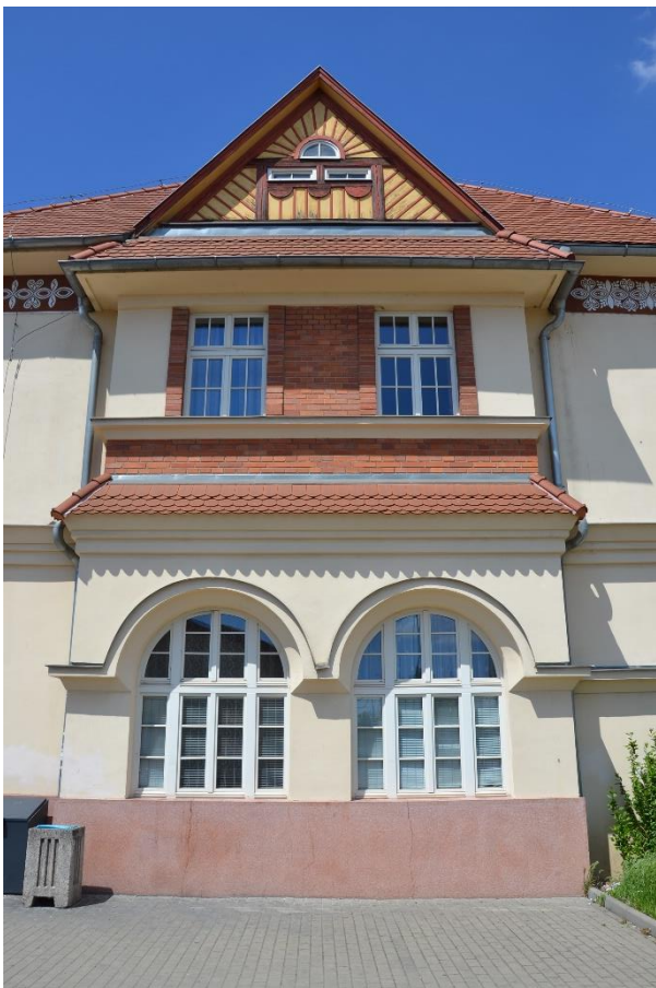
18/ Uherské Hradiště, výpravní budova, pohled na boční rizalit.
