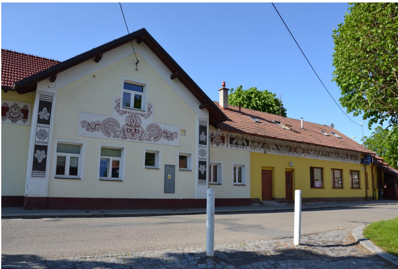
118/ Luhačovice, výpravní budova, pohled od severu.
