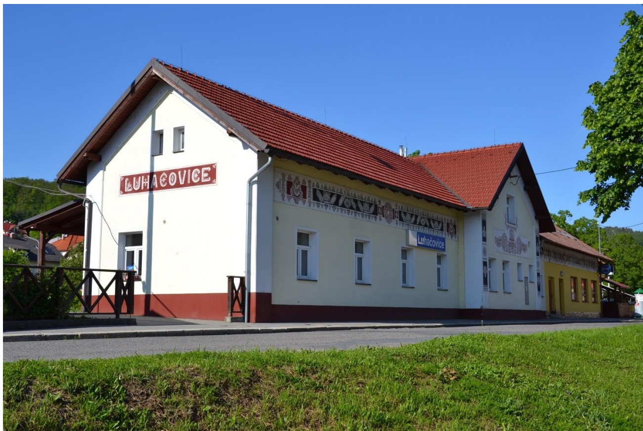
117/ Luhačovice, výpravní budova, 2019, pohled od severovýchodu.
