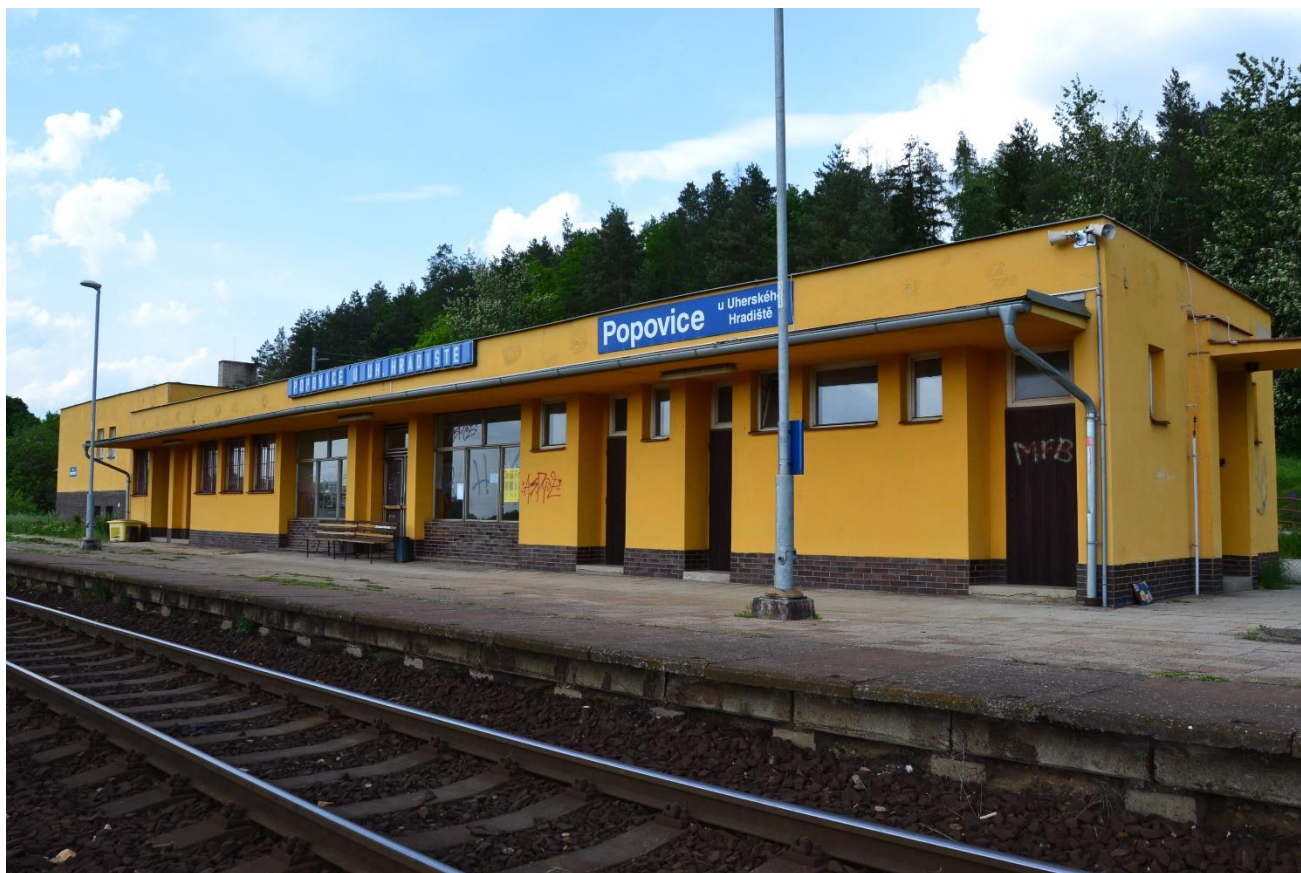
54/ Popovice u Uherského Hradiště, výpravní budova, pohled jihozápadní.
