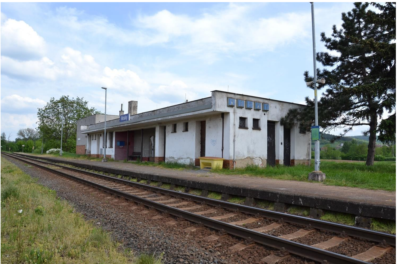
43/ Věskey, výpravní budova, stav 2019, pohled severozápadní.
