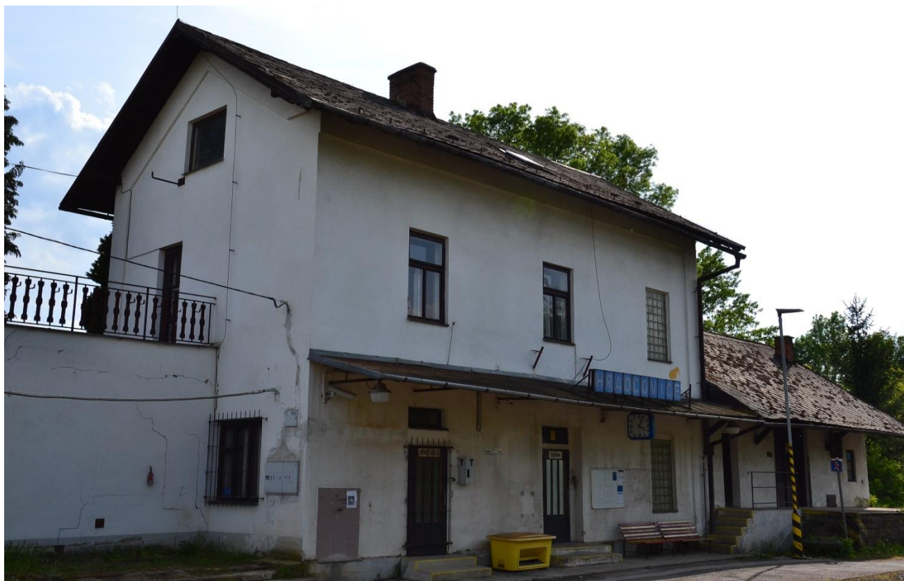
65/ Hradčovice, výpravní budova, stav 2019, pohled od kolejiště.
