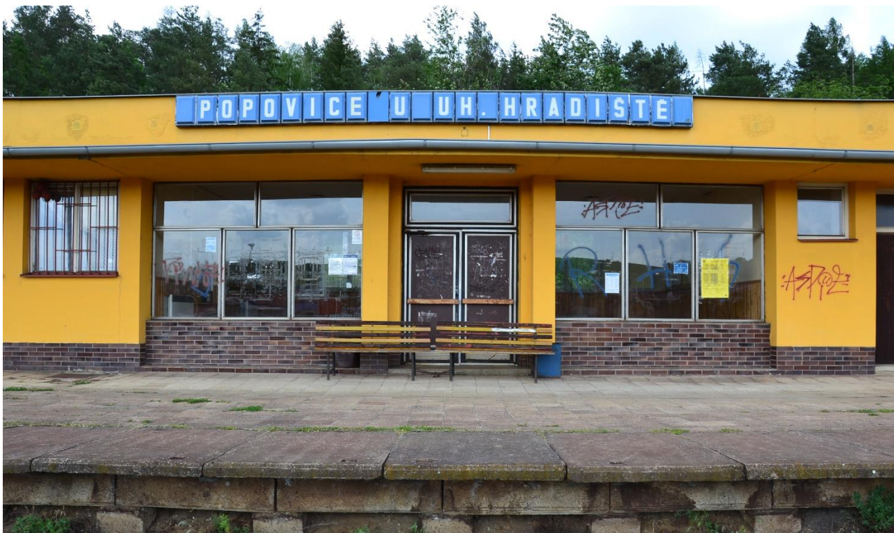
55/ Popovice u Uherského Hradiště, výpravní budova, pohled od kolejiště.
