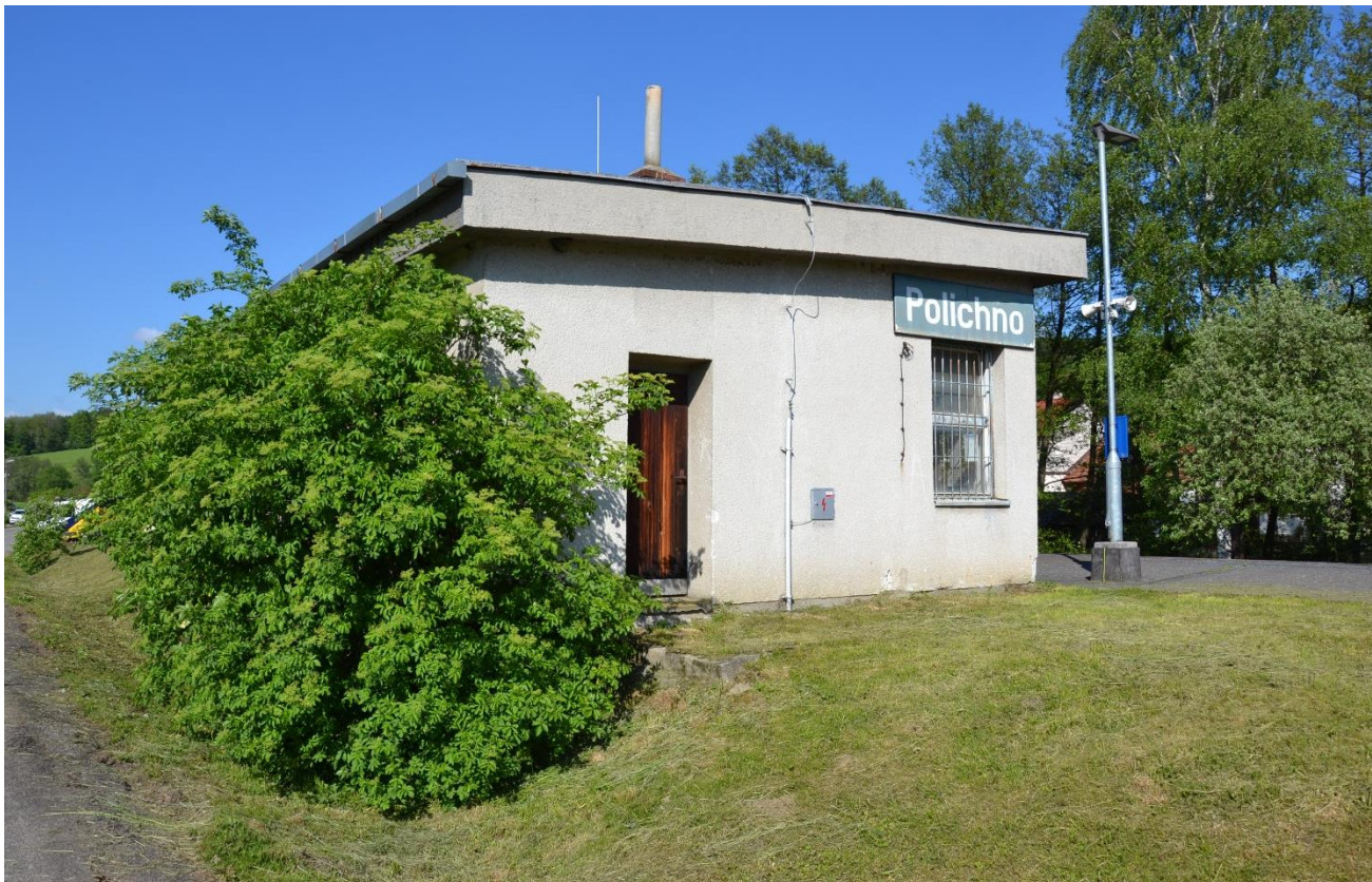
109/ Polichno, čekárna, pohled od jihovýchodu.
