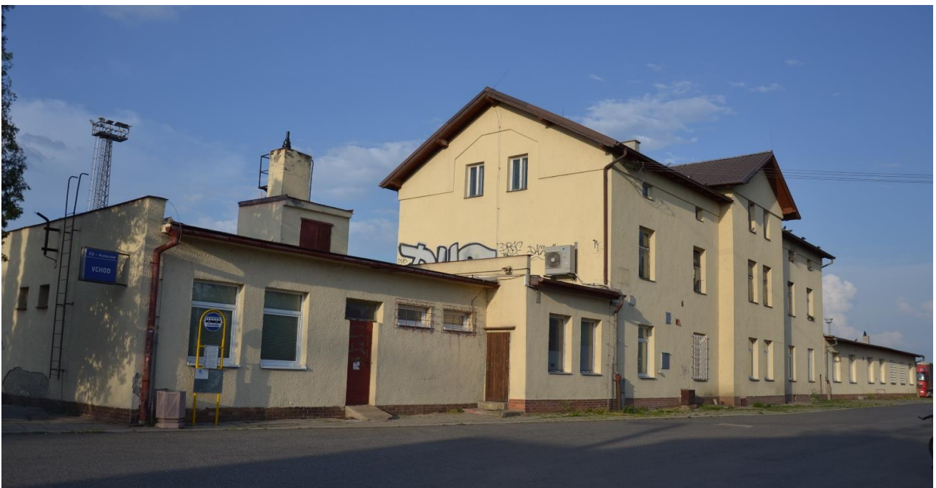
33/ Kunovice, výpravní budova, stav 2019, pohled z přednádraží.
