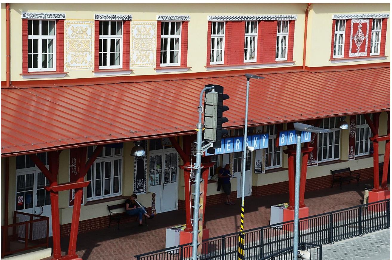
88/ Uherský Brod, výpravní budova, detail nástupištní verandy.
