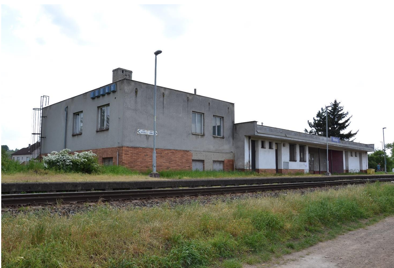
45/ Vésky, výpravní budova, pohled severovýchodní.
