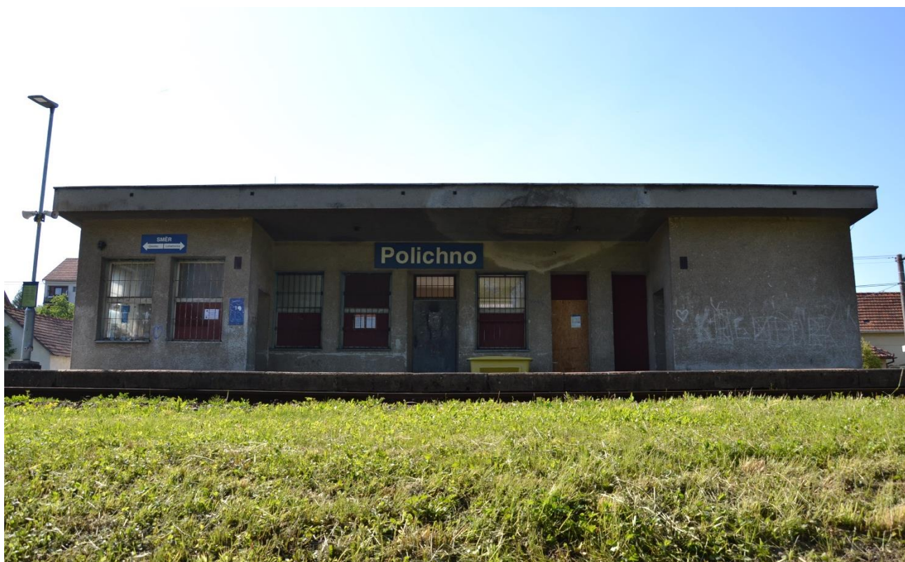
107/ Polichno, čekárna, stav 2019, pohled od kolejiště.
