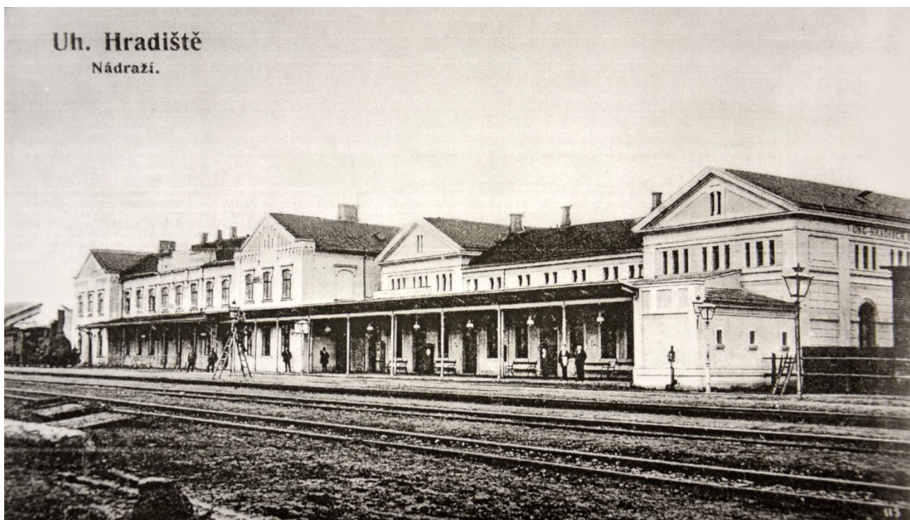
9/ Staré Město, výpravní stanice, kol. 1920.
