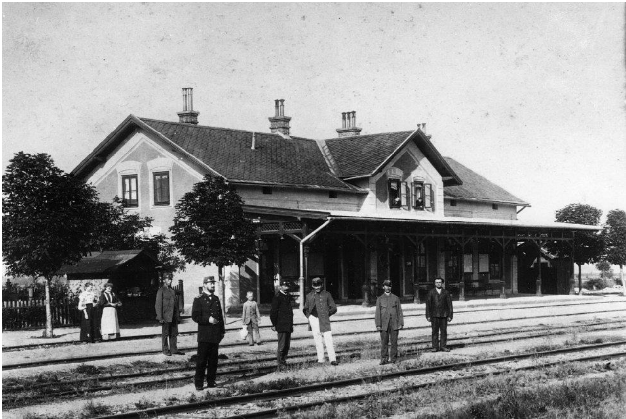
29/ Kunovice, výpravní budova, kol. 1896.
