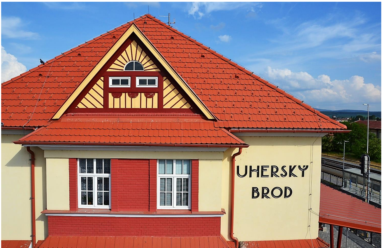
87/ Uherský Brod, detail na štít výpravní budovy, severozápadní pohled.
