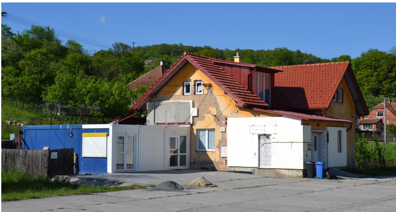
103/ Biskupice u Luhačovic, bývalá výpravní budova z roku 1905, stav 2019, pohled od jihovýchodu.
