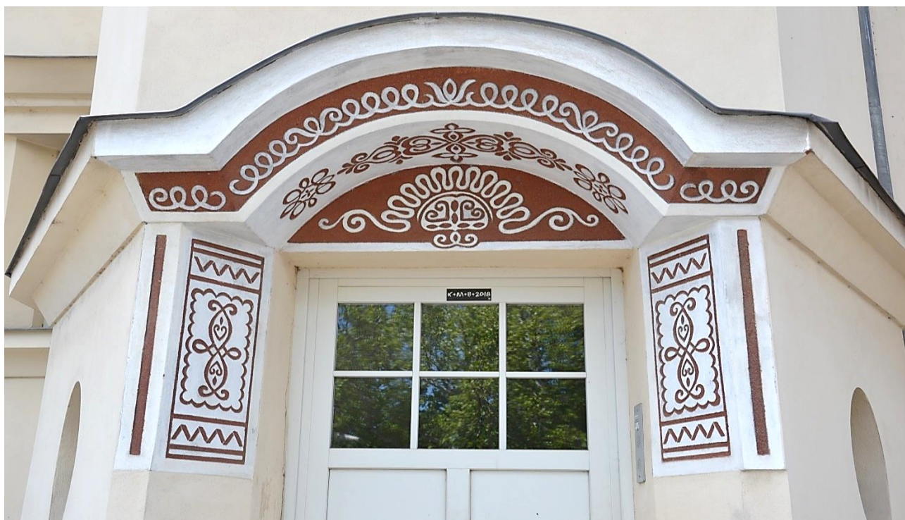
20/ Uherské Hradiště, výpravní budova, detail sgrafitové výzdoby.
