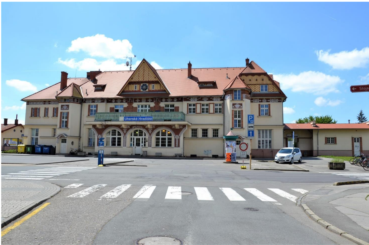
25/ Uherské Hradiště, výpravní budova, stav 2019, pohled z přednádraží.
