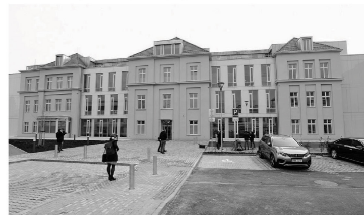
rekonstruovaný Bakešův pavilon, Ing. arch. Vladislav Vrána, 2021
