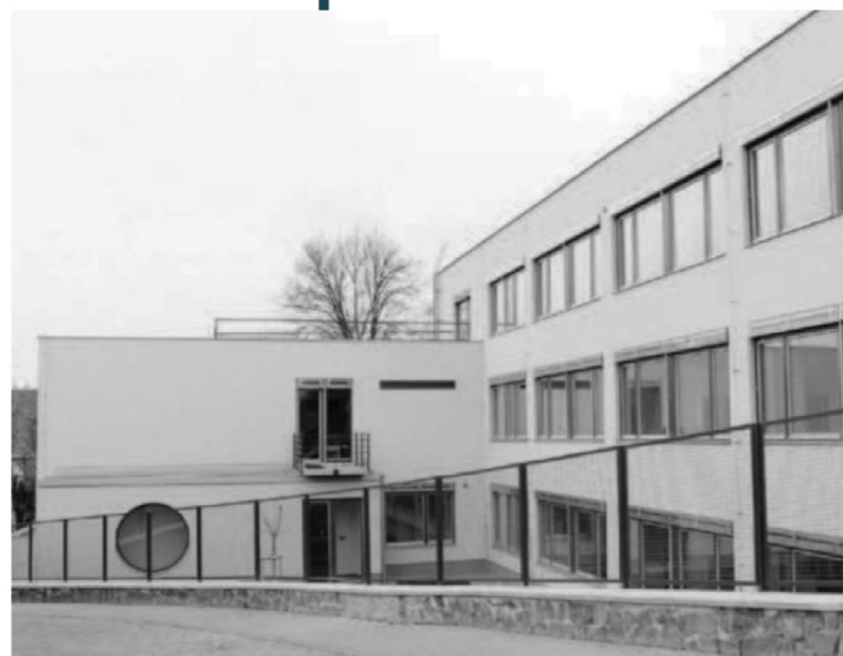
Exteriér rekonstruovaného Morávka pavilonu, 2012
