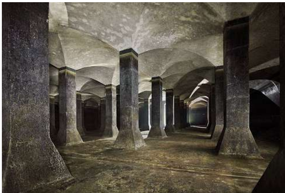
betonový vodojem (severovýchodní)
