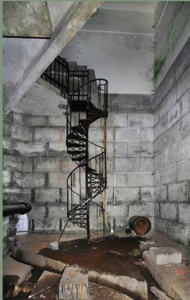
vstupní a armaturní komora betonových vodojemů
