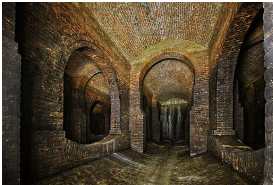
starý vodojem (severovýchodní)
