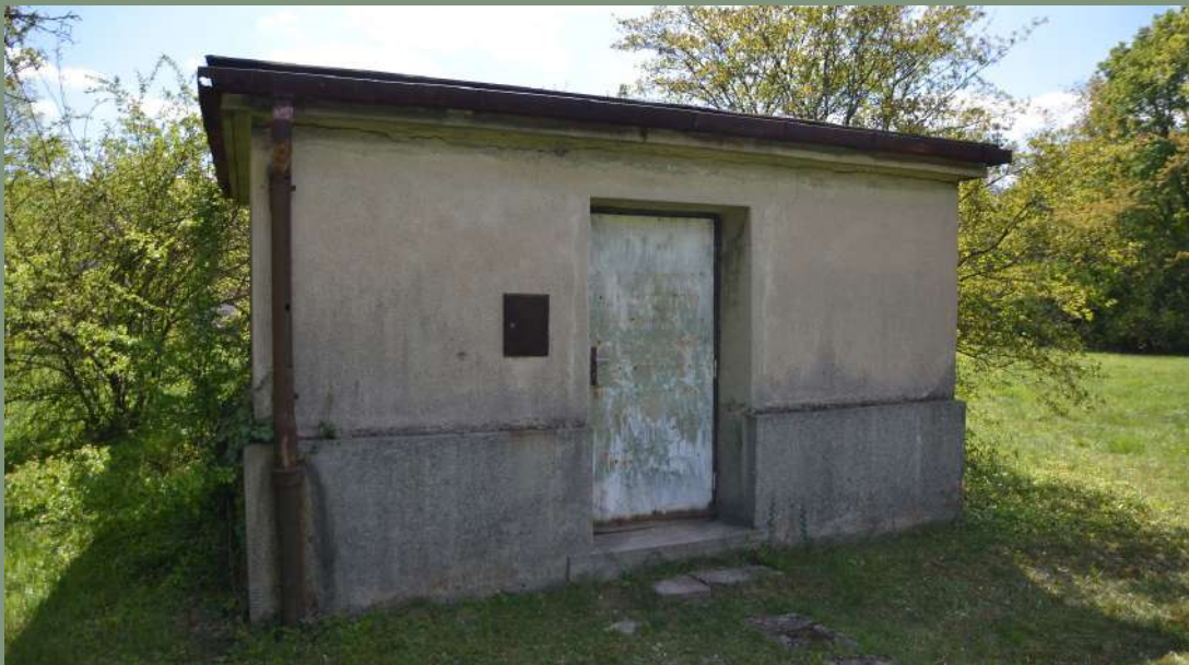
vstup do „jižního“ vodojemu
