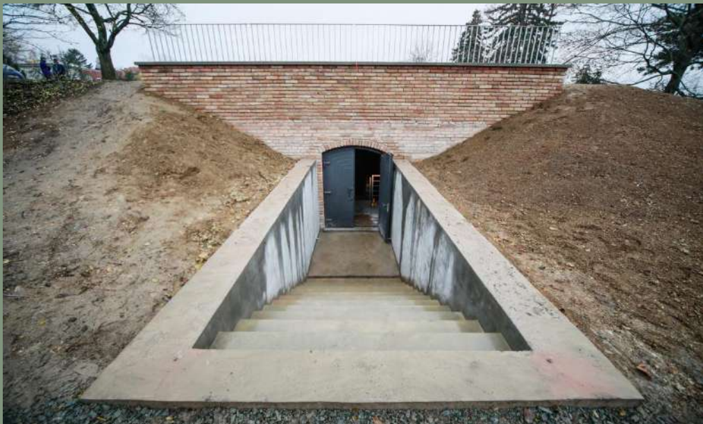
nový vstup do severního vodojemu
