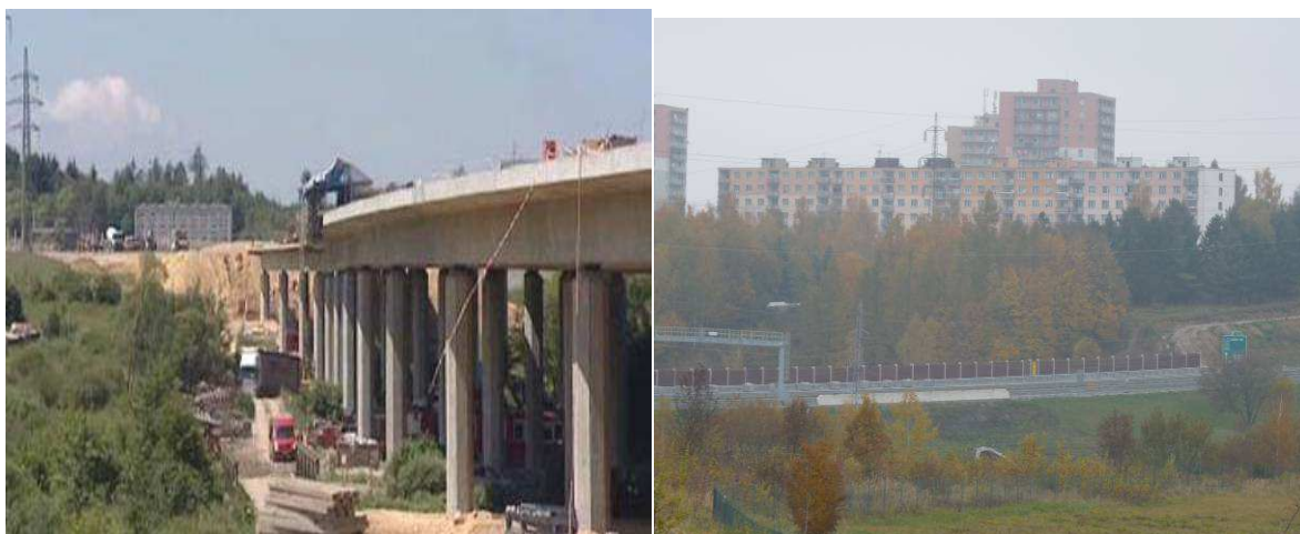
Obr. 6: Výstavba rychlostní silnice R6
