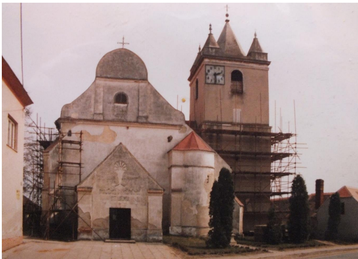
Příloha č. 96 a 97: Rekonstrukce kostela roku 1995.
