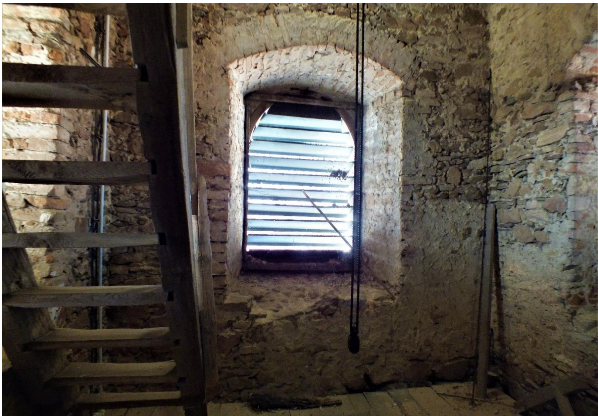
Příloha č. 52 a 53: Interiér renesanční věže. Foto z roku 2019.
