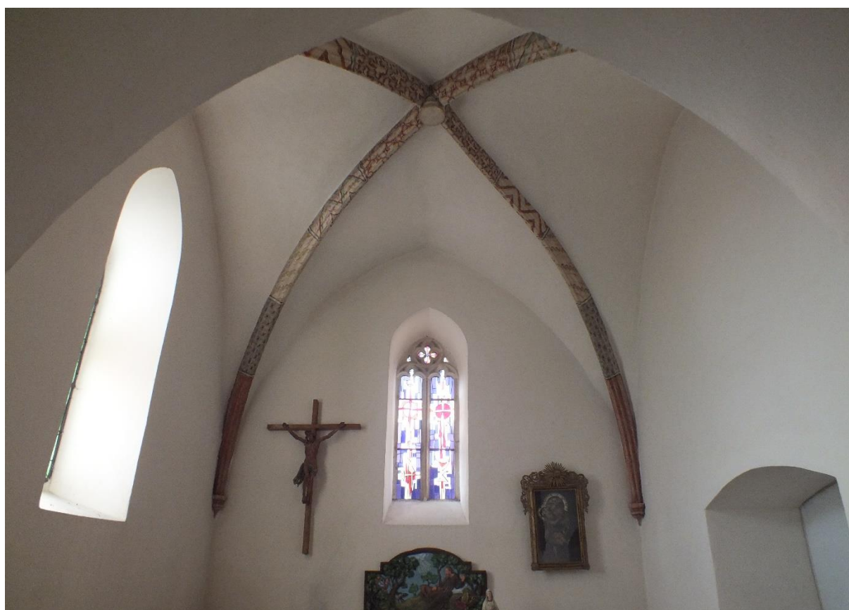
Příloha č. 78: Pohled na gotické klenutí kaple pod věží. Foto z roku 2019.
