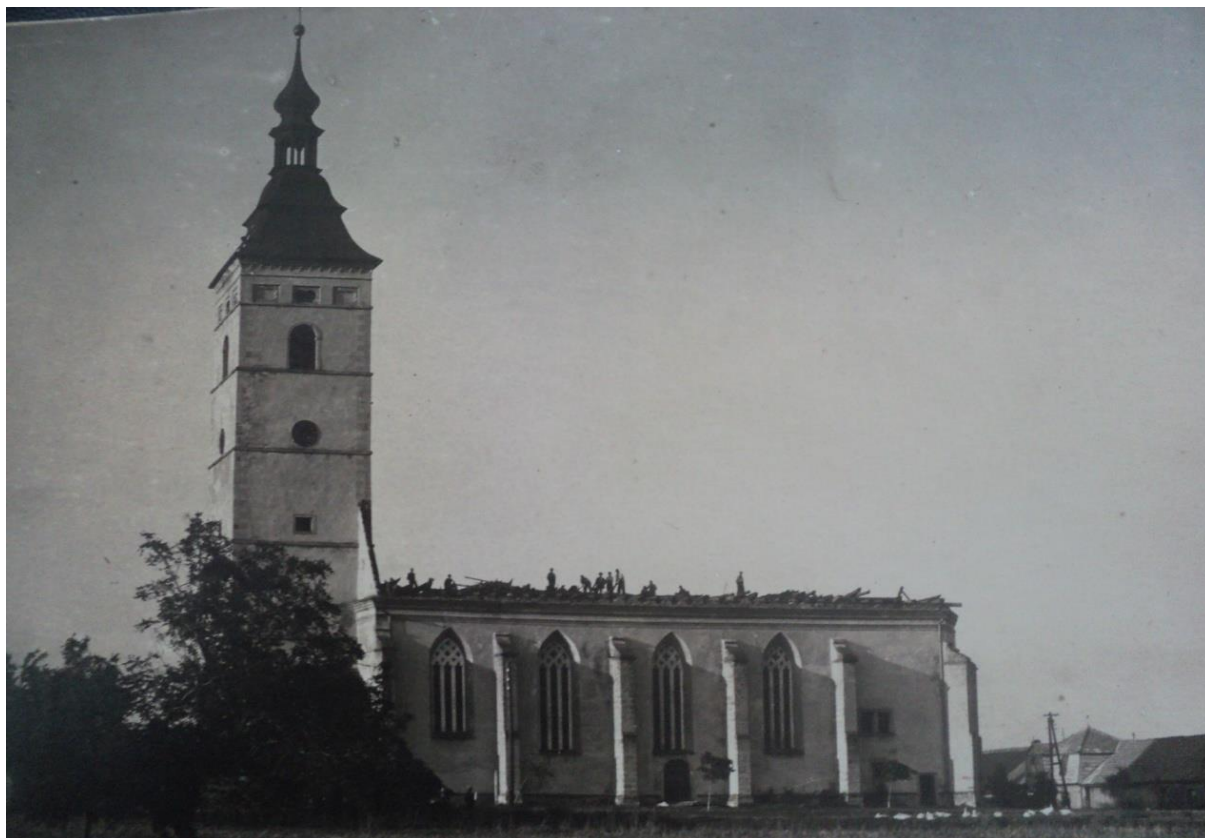
Příloha č. 28: Fotografie kostela z roku 1946. Snímek zaznamenává následky vichřice, která strhla celou střechu včetně krovů a odnesla ji až do míst současného hřbitova na kraji obce.
