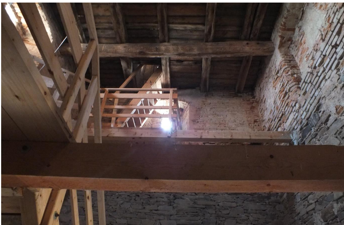
Příloha č. 90: Interiér věže. Renesanční přístavba – schodišťová část. Foto z roku 2019.
