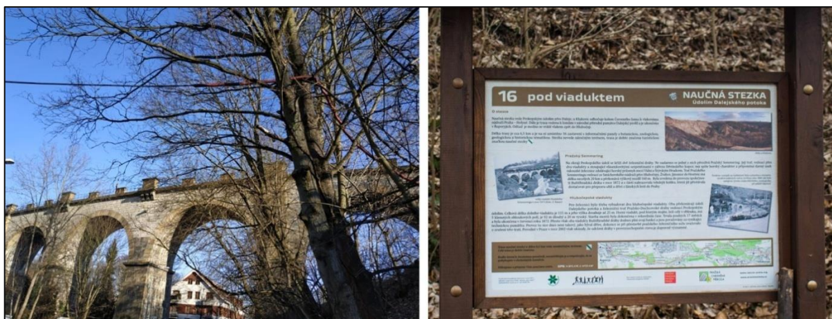
Foto č. 16 – Vlevo pohled zespodu na velký viadukt, vpravo informační tabule.
