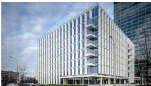
Obr. 13: Budova City Green Court, Praha, Česká Republika (Skanska, ©2018)
