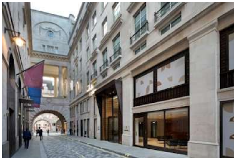
Obr. 6: Atrium objektu 7 Air Street, Londýn, Velká Británie (BRE, ©2018)
