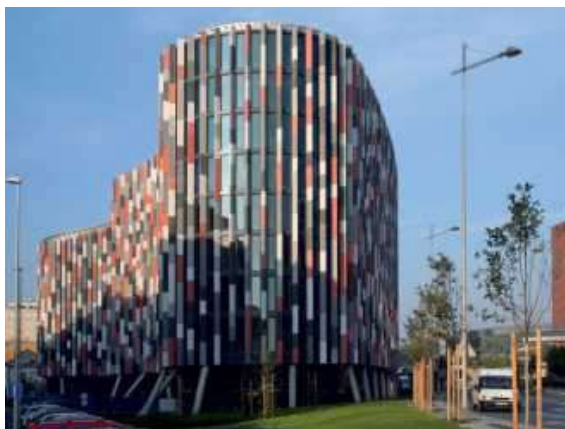
Obr. 12: Budova Main Point Karlín, Praha, Česká republika (VENTAC, 2011)
