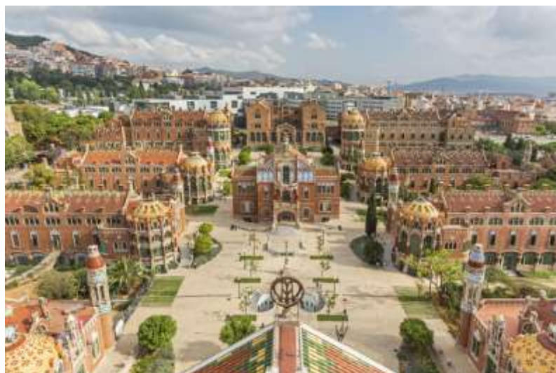
Obr. 15: Studie historické nemocnice Recinte Modernista Hospital Sant Pau, Barcelona, Španělsko (ISABEL BENNASAR, ©2011)
