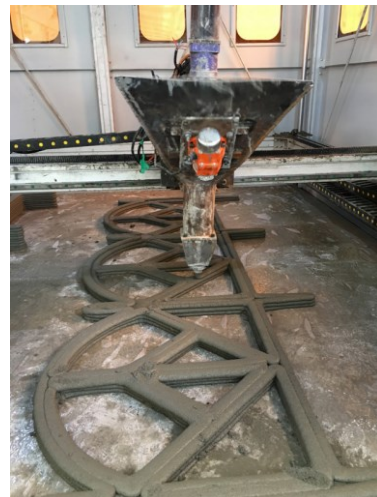
Obr. 4 Průběh tisku metody CP [23]
