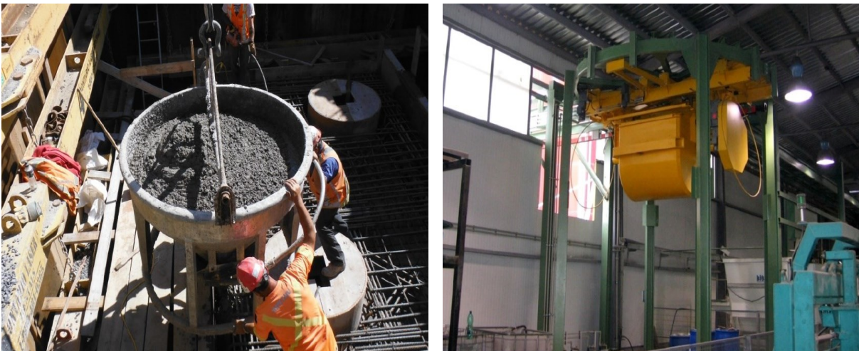
Obr. 34 Sekundární doprava betonové směsi zleva, jeřábem v koši, podvěsnými vozíky [35]
