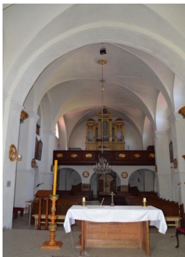
49. Kostel sv. Jana Křtitele, Frýdek – hlavní loď zaklenutá velnou klenbou s lunetovými výsečemi s hranami vytažených do hřebínků
