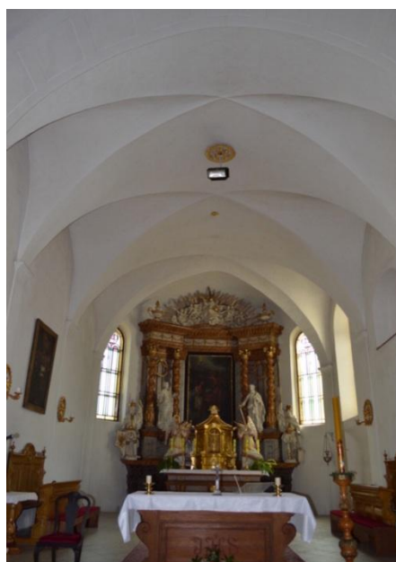
51. Kostel sv. Jana Křtitele, Frýdek – presbytář zaklenutý valenou klenbou s lunetovými výsečemi s hranami vytažených do hřebínků
