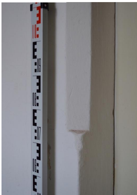
24. Frýdecký zámek, Frýdek – detail ostění nejstaršího gotického portálu ve 3. podlaží jižního paláce – ostění s okosením výběžku se zhoupnutím v profilaci
