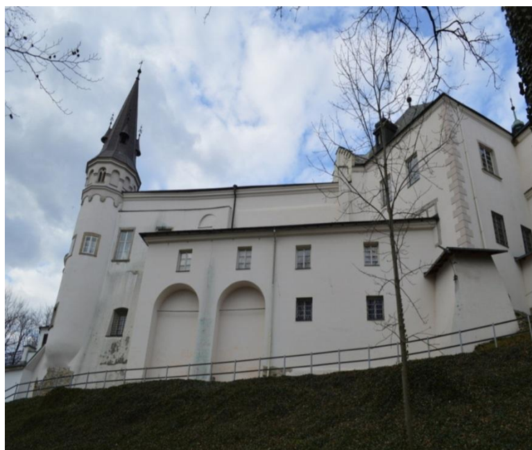
39. Frýdecký zámek, Frýdek – pohled od jihu na arkýřovou věž a renesanční terasu
