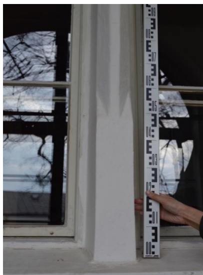
30. Frýdecký zámek, Frýdek – detail okoseného ostění s jehlancovými výběžky sdruženého reprezentativního okna ve druhém patře východního křídla
