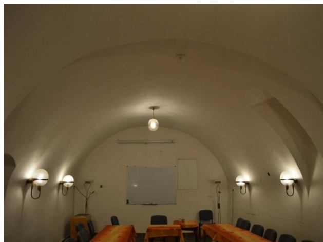
20. Frýdecký zámek, Frýdek – propojené místnosti zaklenuté valenou klenbou, 1. podlaží jižního paláce
