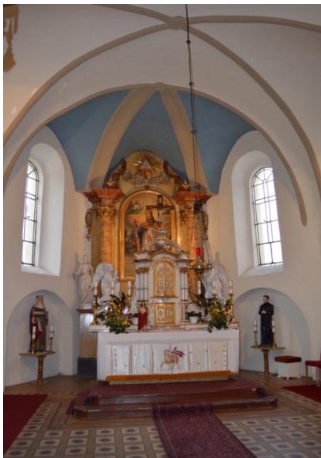
66. Kostel sv. Martina, Skalice – pohled na východ, presbytář s trojbokým závěrem zaklenutý jedním polem křížové klenby
