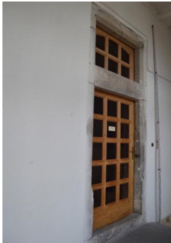
27. Frýdecký zámek, Frýdek – kamenný gotický portál s nadsvětlíkem ve druhém patře východního křídla
