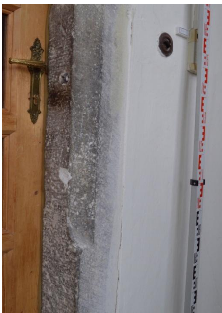
28. Frýdecký zámek, Frýdek – detail ostění s jehlancovým výběžkem kamenného gotického portálu s nadsvětlíkem ve druhém patře východního křídla
