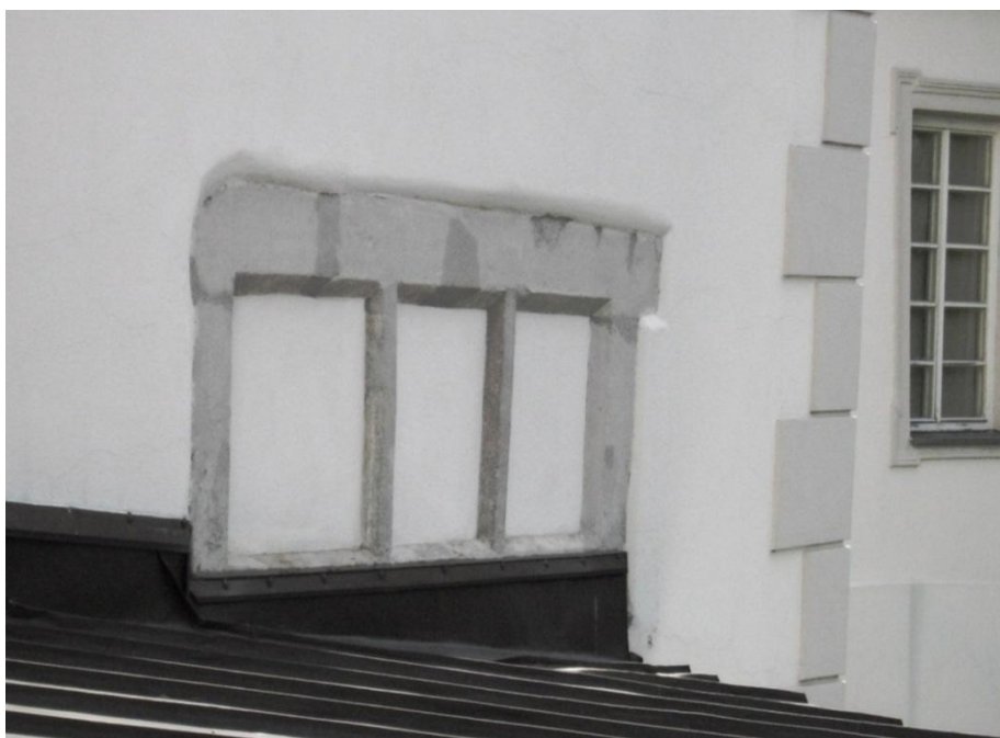
21. Frýdecký zámek, Frýdek – třídílné zazděné okno s okosenými hranami, 2. podlaží jižního paláce
