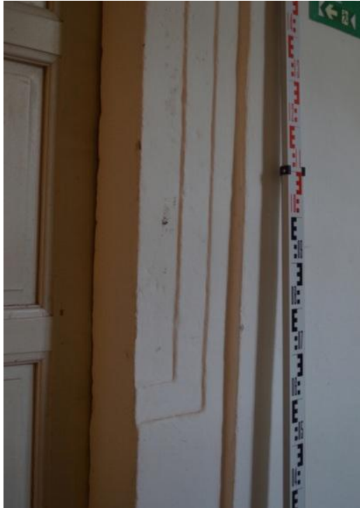
34. Frýdecký zámek, Frýdek – detail renesančního portálu s ostěním s pravouhle zalomenou profilací – ve 3. podlaží jižního křídla
