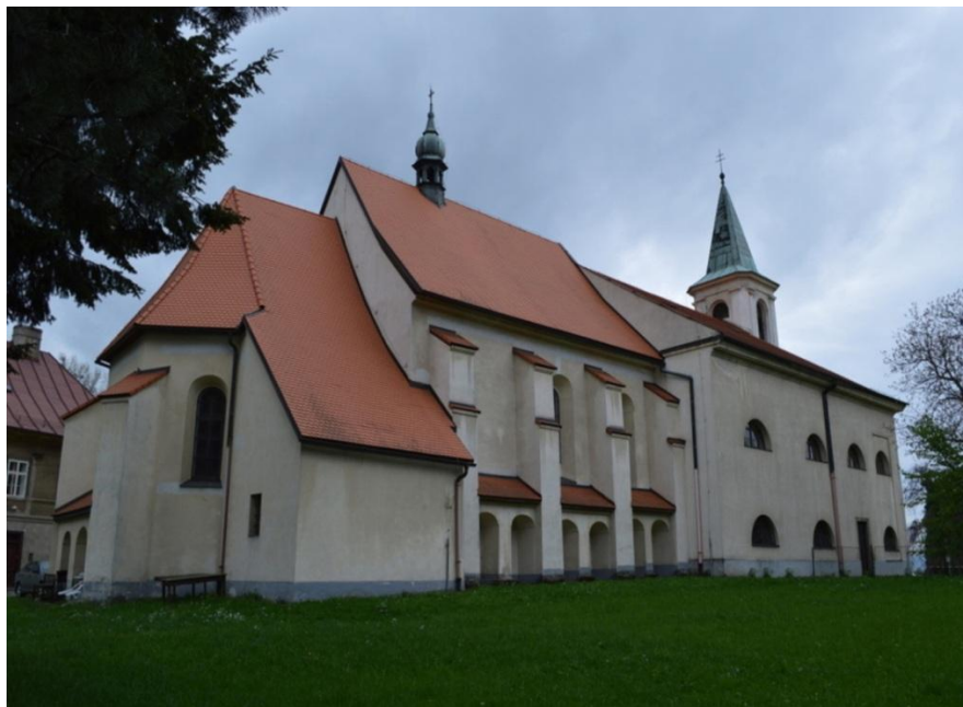
63. Kostel sv. Martina, Skalice – pohled na severní stranu kostela
