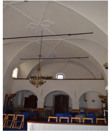
62. Kostel sv. Jošta, Frýdek – západní pohled na loď zaklenutou valenou s lunetovými výsečemi a kruchtou s hladkou poprsní
