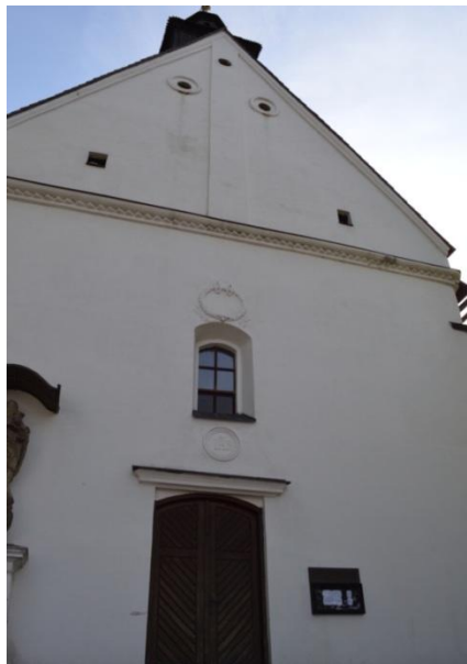
60. Kostel sv. Jošta, Frýdek – detail západního průčelí, pilastr členící trojúhelníkový štít, malá obdélná a kruhová okna se šambránami
