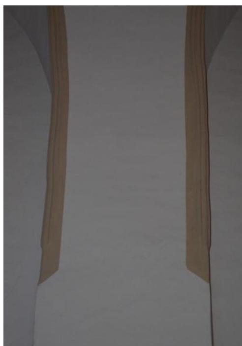
70. Kostel sv. Martina, Skalice – detail třísvazkových maltových prutů plynule svedených na přízední polopolíř v hlavní lodi
