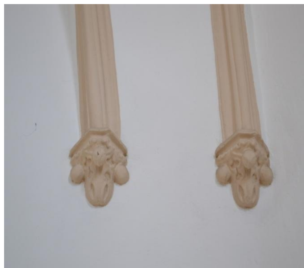
14. Kostel sv. Jakuba Většího, Místek – profilovaná maltová žebra s oblouny a výžlabky, vegetabilní konzoly s listovým a bobulemi
