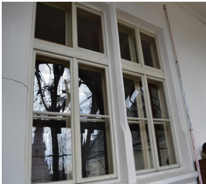
29. Frýdecký zámek, Frýdek – sdružené reprezentativní okno s okoseným ostěním s jehlancovými výběžky ve druhém patře východního křídla
