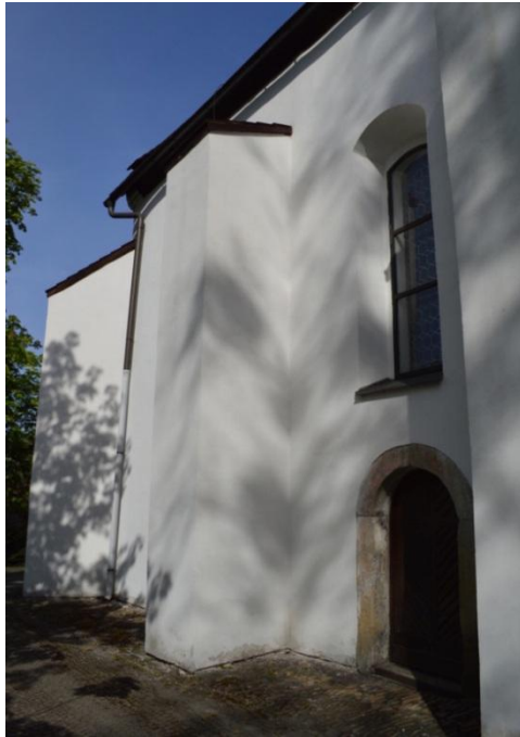
58. Kostel sv. Jošta, Frýdek – pohled na jižní fasádu s masivním pilířem s pultovou stříškou, segmentově zalomeným oknem a bočním kamenným portálem
