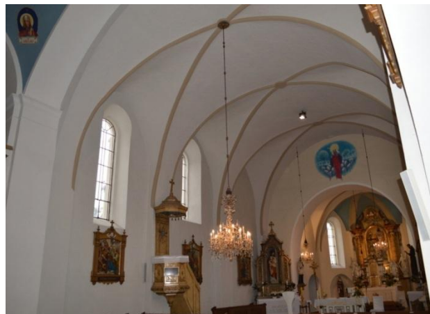
65. Kostel sv. Martina, Skalice – pohled na východ, hlavní loď zaklenutá valenou klenbou s lunetovými výsečemi
