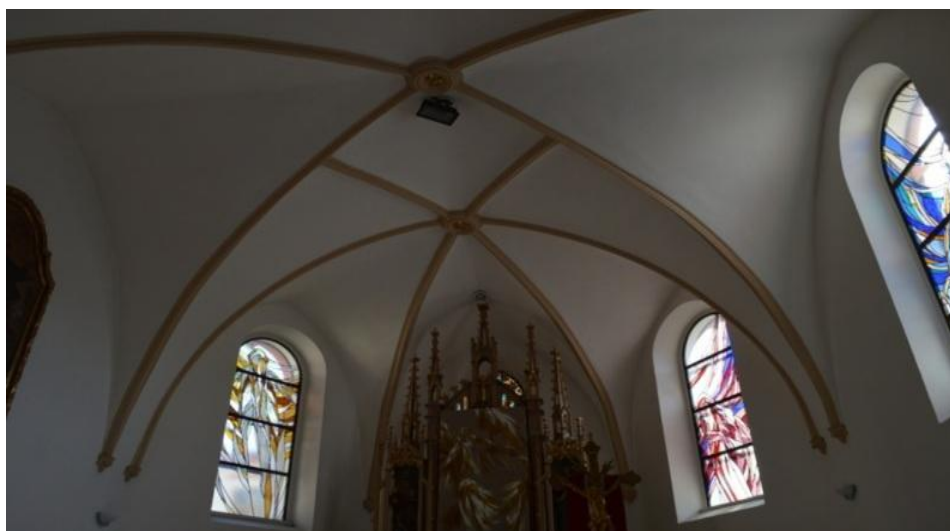
12. Kostel sv. Jakuba Většího, Místek – v jádru gotický presbytář, zaklenut konchou s lunetovými výsečemi a dvěma poli křížové klenby
