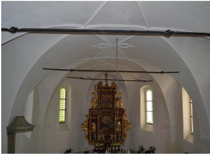
61. Kostel sv. Jošta, Frýdek – východní pohled na polygonální presbytář zaklenutý valenou klenbou s lunetovými výsečemi tvořící jednoduchou síť s ornamentem
