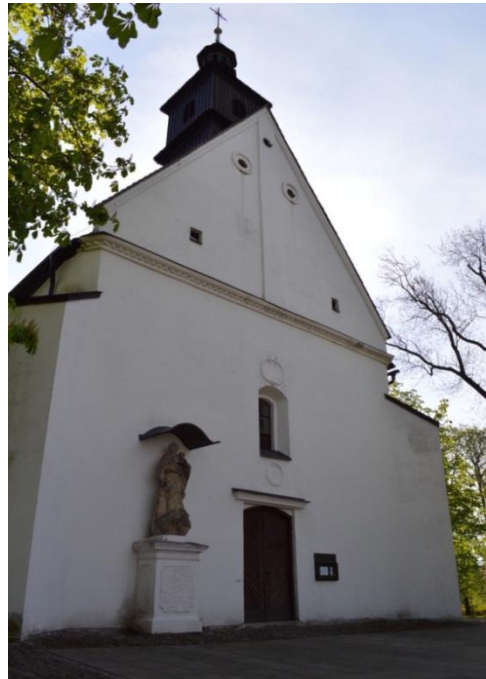
59. Kostel sv. Jošta, Frýdek – pohled na západní průčelí s trojúhelníkovým štítem, profilovanou římsou a zubořezem a hlavním vstupem se segmentovým záklenkem
