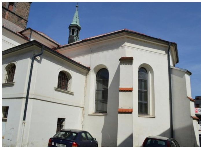
50. Kostel sv. Jana Křtitele, Frýdek – presbytář s pětibokým závěrem, na nárožích s opěráky s pultovými stříškami
