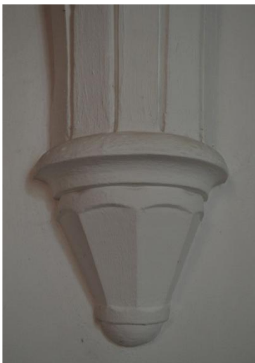
54. Kostel sv. Jana Křtitele, Frýdek – odstupňovaná jehlancová římsová konzola
