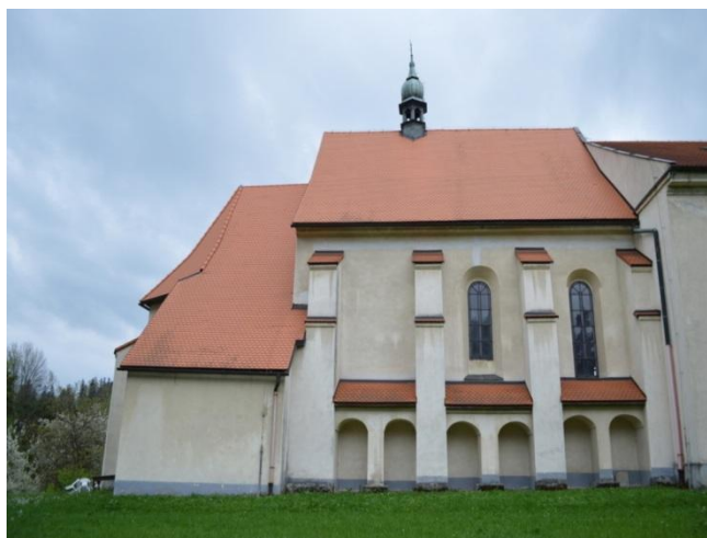
67. Kostel sv. Martina, Skalice – pohled na severní stranu, presbytář a hlavní loď podepřeny opěrnými pilíři
