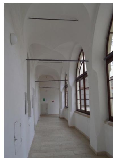
38. Frýdecký zámek, Frýdek - arkádové chodby zaklenuté valenou klenbou, lunetovými výsečemi s hřebínky, 1. patro severního křídla
