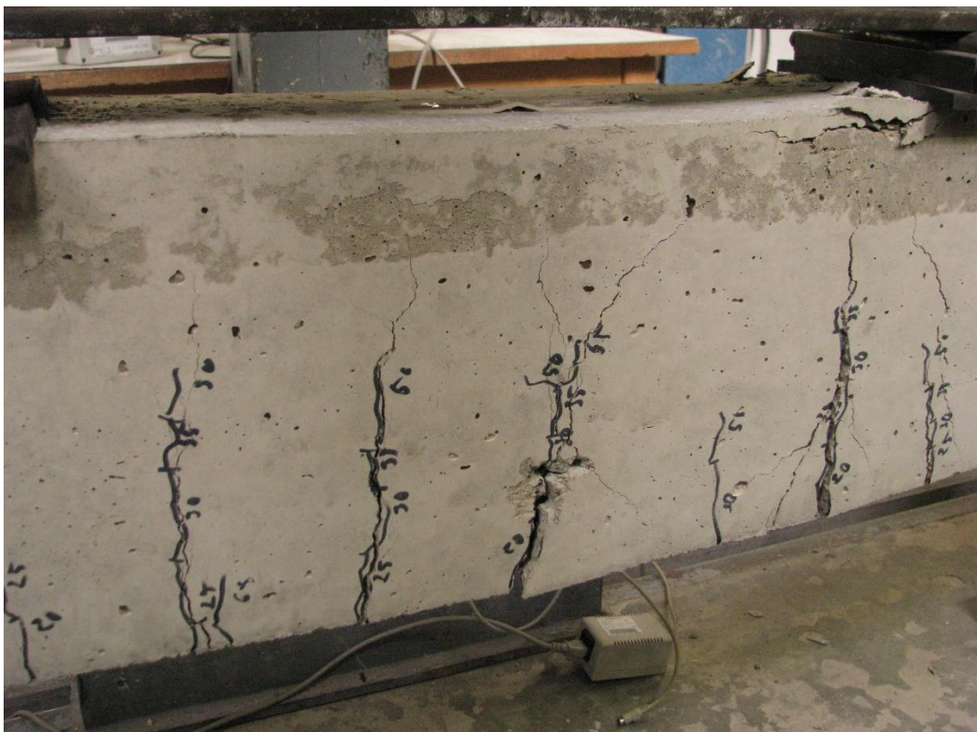
Obr. 2.32 Trhliny při kolapsu nosníku
