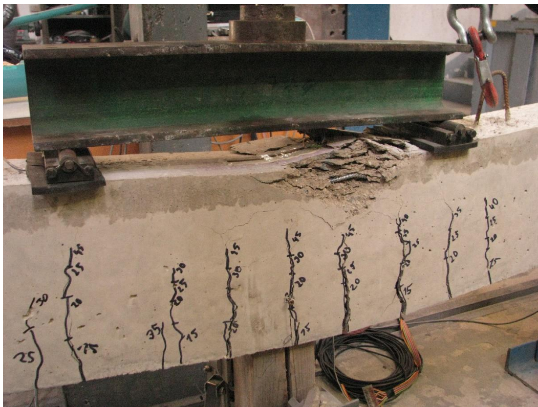
Obr. 2.21 Drcení betonu způsobené vybočením tlačené výztuže
