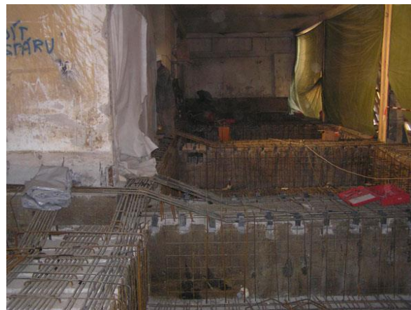
Obr. 3.7 Zvýšení únosnosti základů dobetonováním [4-1]
