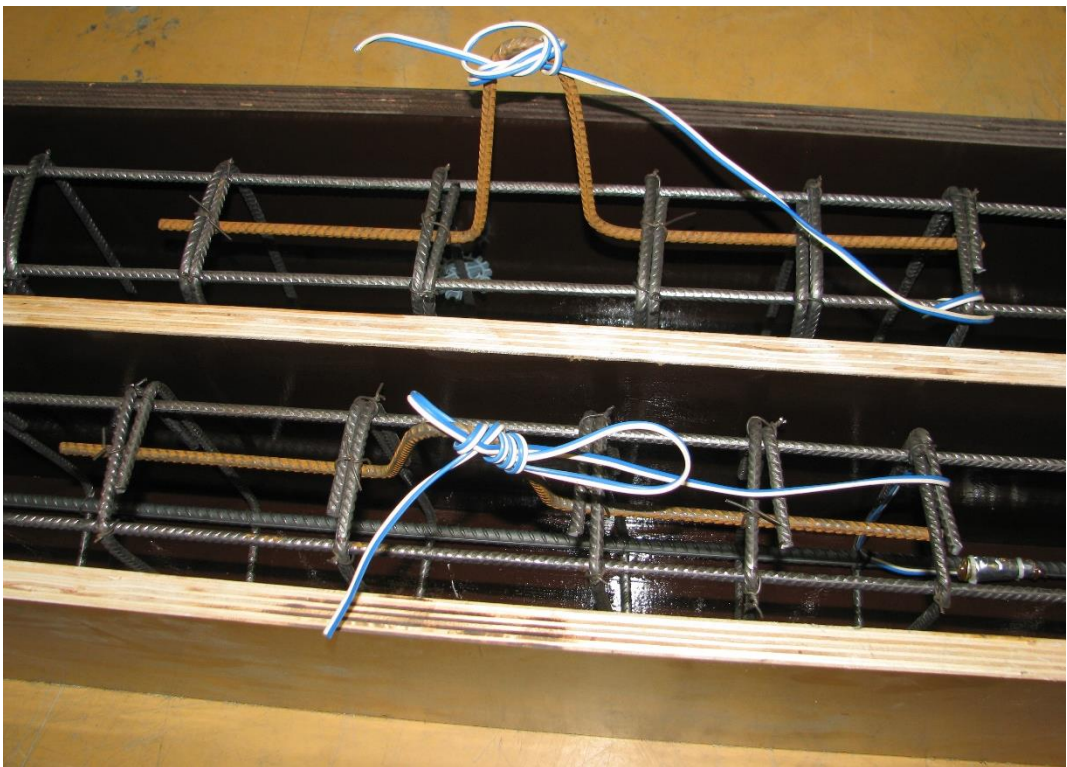
Obr. 2.4 Příprava držáků pro přesun ŽB nosníků
