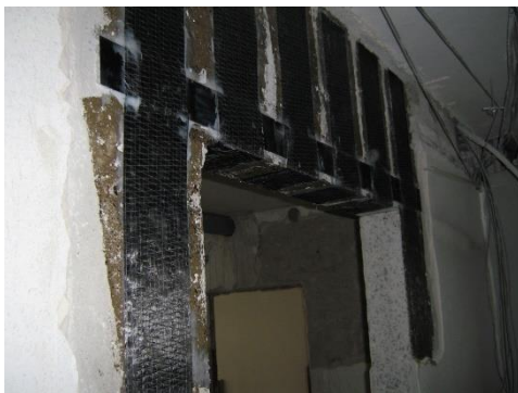
Obr. 3.1 Externí zesilování překlady [4-7]
