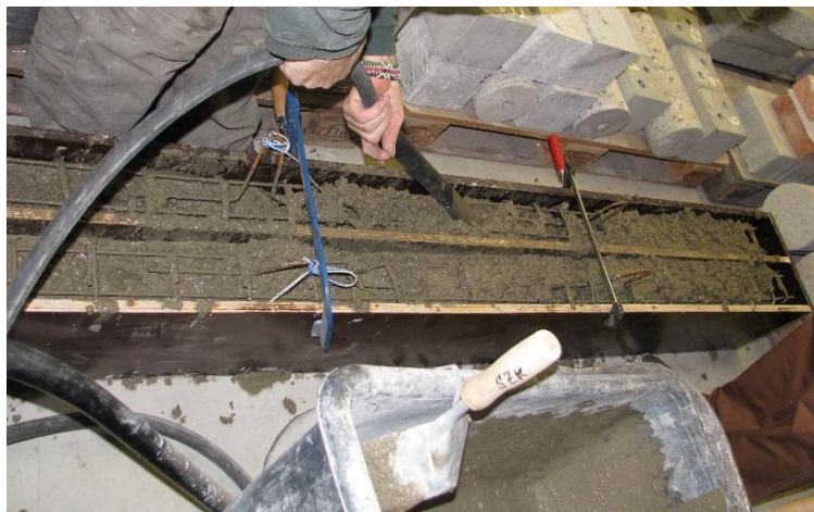
Obr. 5.4 vibrování betonové směsi
