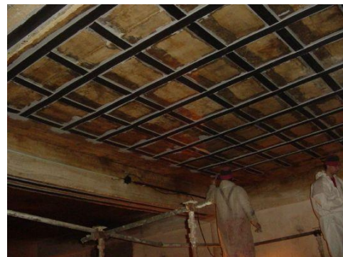
Obr. 3.2 Zesilování stropní konstrukce [4-2]
