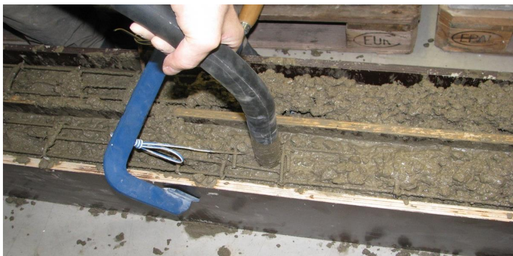
Obr. 2.6 Zavibrování čerstvé betonové směsi
