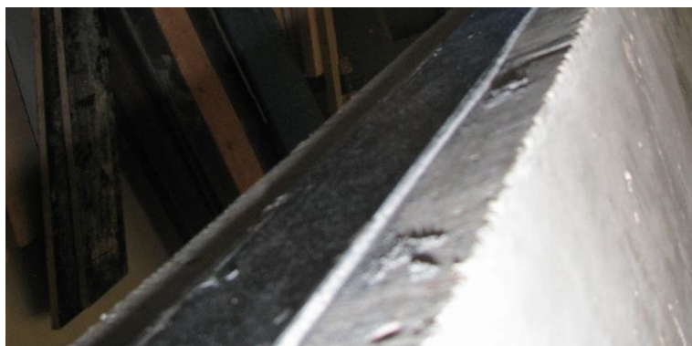
Obr. 5.8 Lepená cfk lamela
