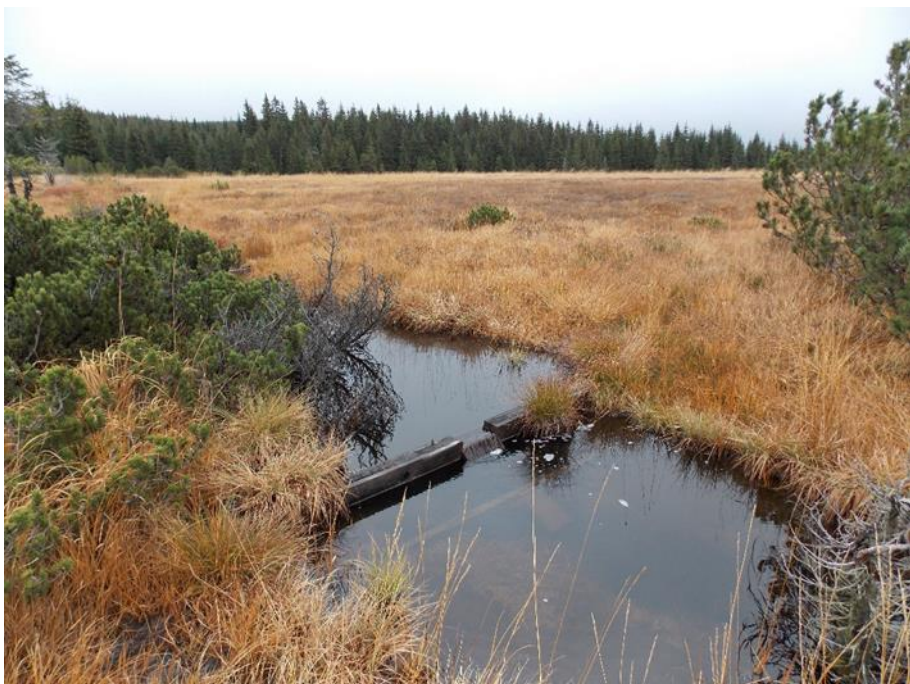
Obrázek 7: Dřevěné přehrážky – revír Jizerka, lesní správa Frýdlant
